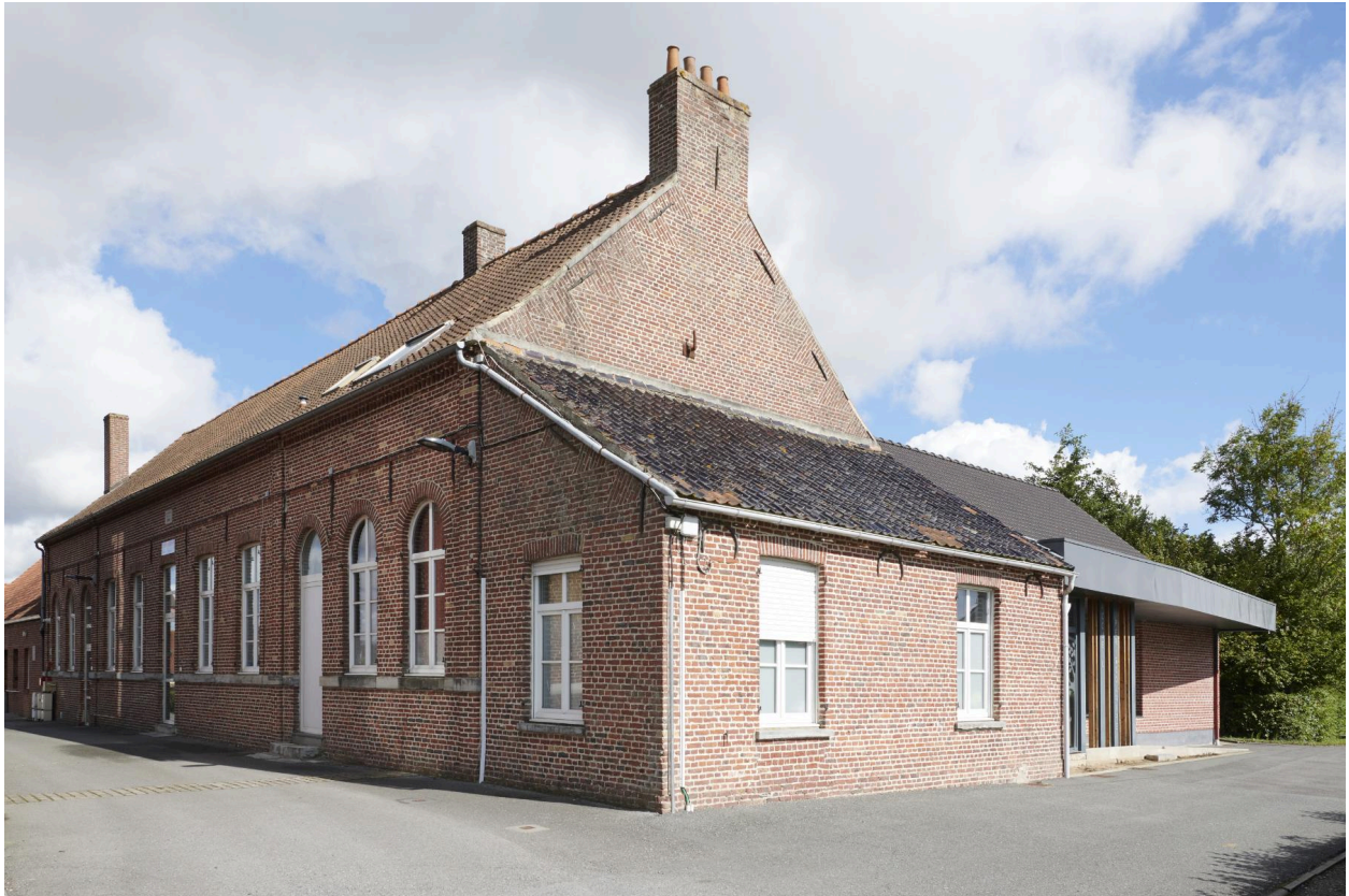
Façade sur rue ouest et pignon sud.
