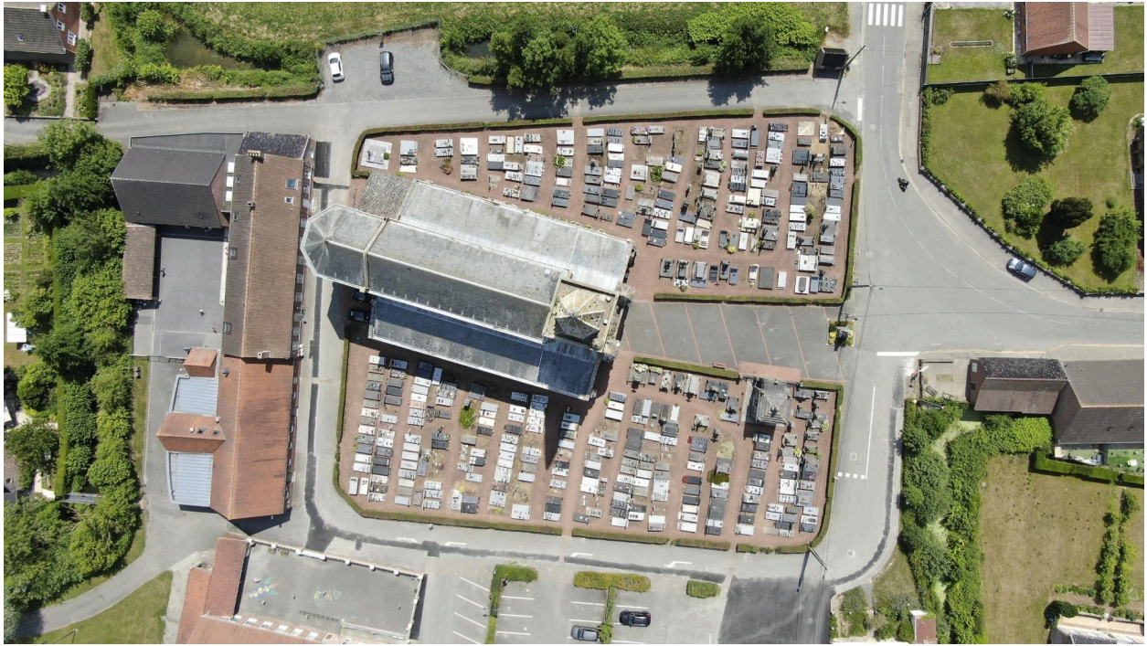
Vue zénithale de l'église.
