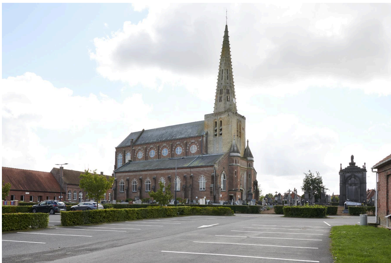
Vue de l'église dans son environnement local.
