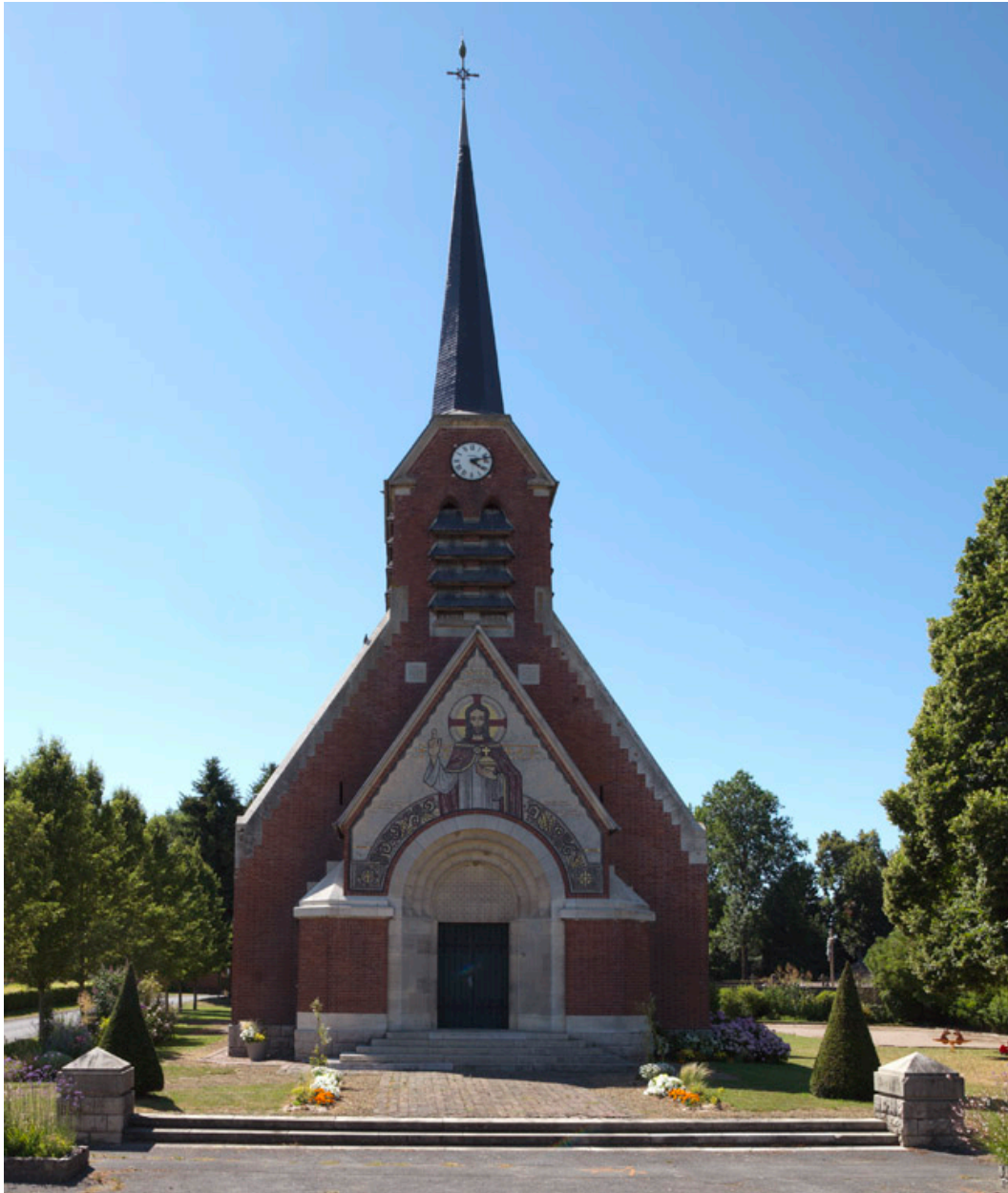
Vue de la façade est.
