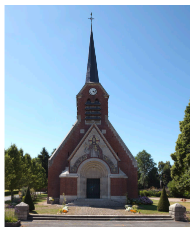
Vue de la façade est.
