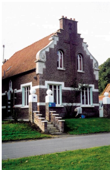
Presbytère. Phot. Gilles-Henri Bailly IVR22_20158005331NUCA
