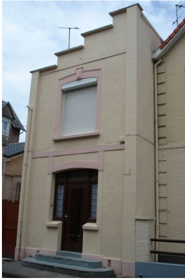
Vue générale. Phot. Julie Faure IVR31_20066200116NUCA
