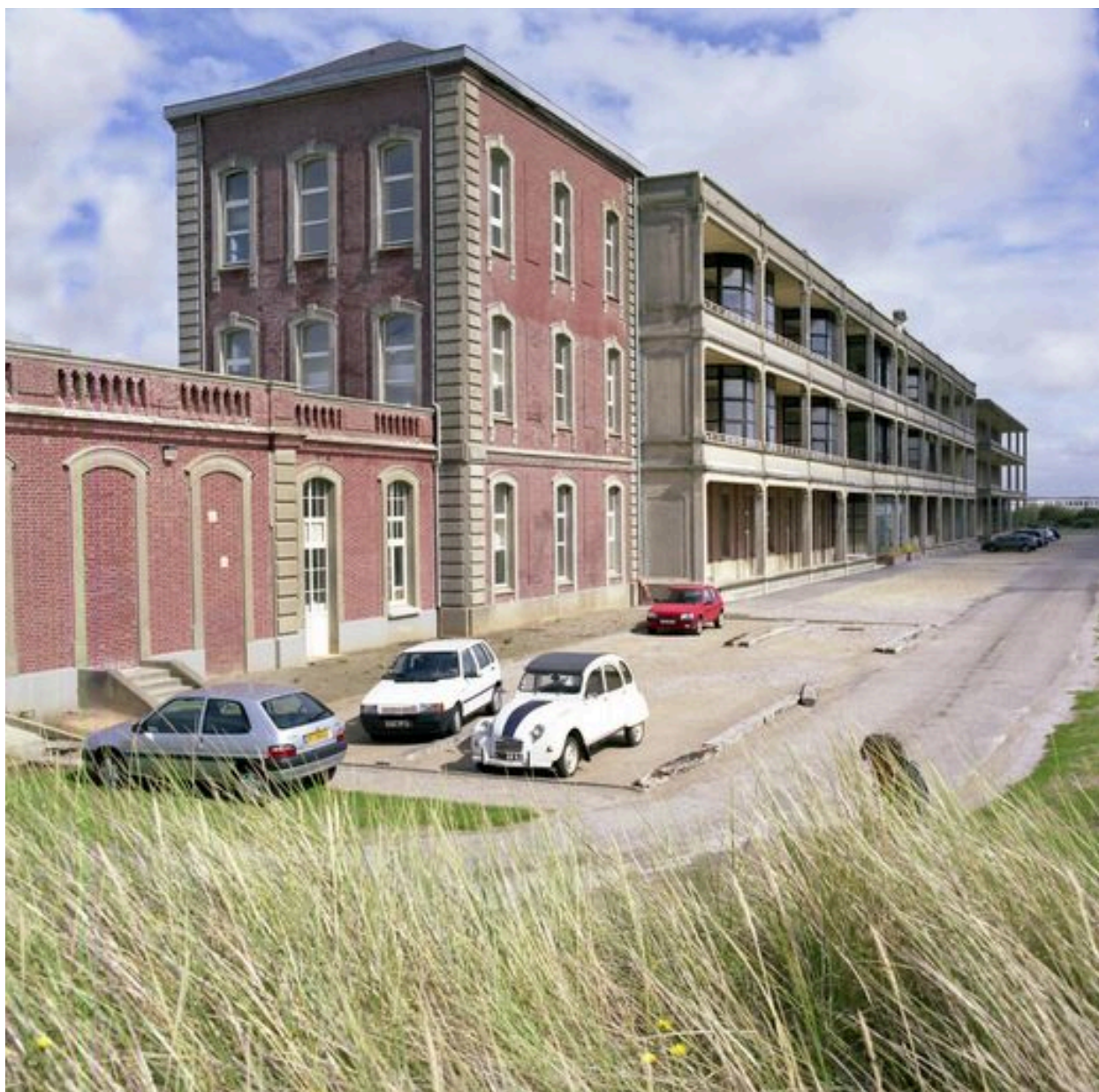
Corps de logis méridional de l'édifice primitif, galeries de cure superposées en béton armé ajoutées en 1913 et dans les années 1950 le long de sa face sud, élévation de ces galeries, vue en enfilade prise depuis l'ouest.
