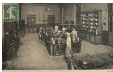
Cuisine, vue intérieure générale.
