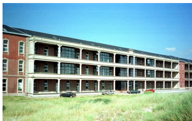
Corps de logis principal, bâtiment méridional, galeries de cure superposées en béton armé ajoutées en 1913 le long du côté ouest de sa face sud, élévation de ces galeries, vue de trois-quarts gauche.
