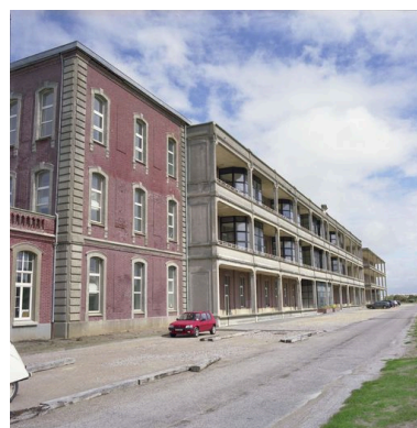
Corps de logis méridional de l'édifice primitif, galeries de cure superposées en béton armé ajoutées en 1913 et dans les années 1950 le long de sa face sud, élévation de ces galeries, vue en enfilade prise depuis l'ouest.
