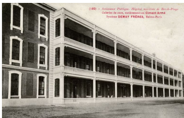
Corps de logis méridional de l'édifice primitif, état après l'ajout en 1913 de galeries de cure superposées en béton armée sur une partie de sa face sud, détail de l'élévation de ces galeries, vue prise de trois-quarts gauche. Phot. Eddy Stein IVR31_20086200002NUCB
