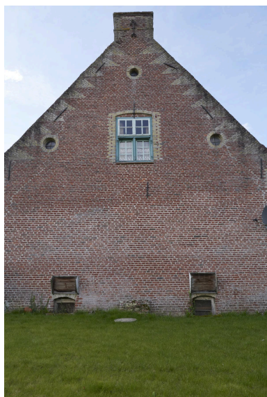
Détail du pignon est. Phot. Delphine Volto Jourdan IVR32_20245903061NUCA
