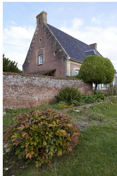
Détail du pignon ouest. Phot. Delphine Volto Jourdan IVR32_20245903057NUCA
