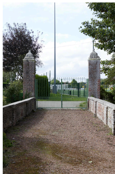
Détail des pilastres situées à l'entrée de la propriété (côté ouest). Phot. Delphine Volto Jourdan IVR32_20245903064NUCA
