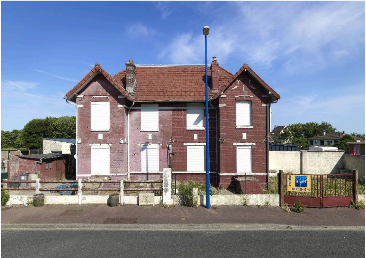
Détail d'une unité de quatre habitations.
