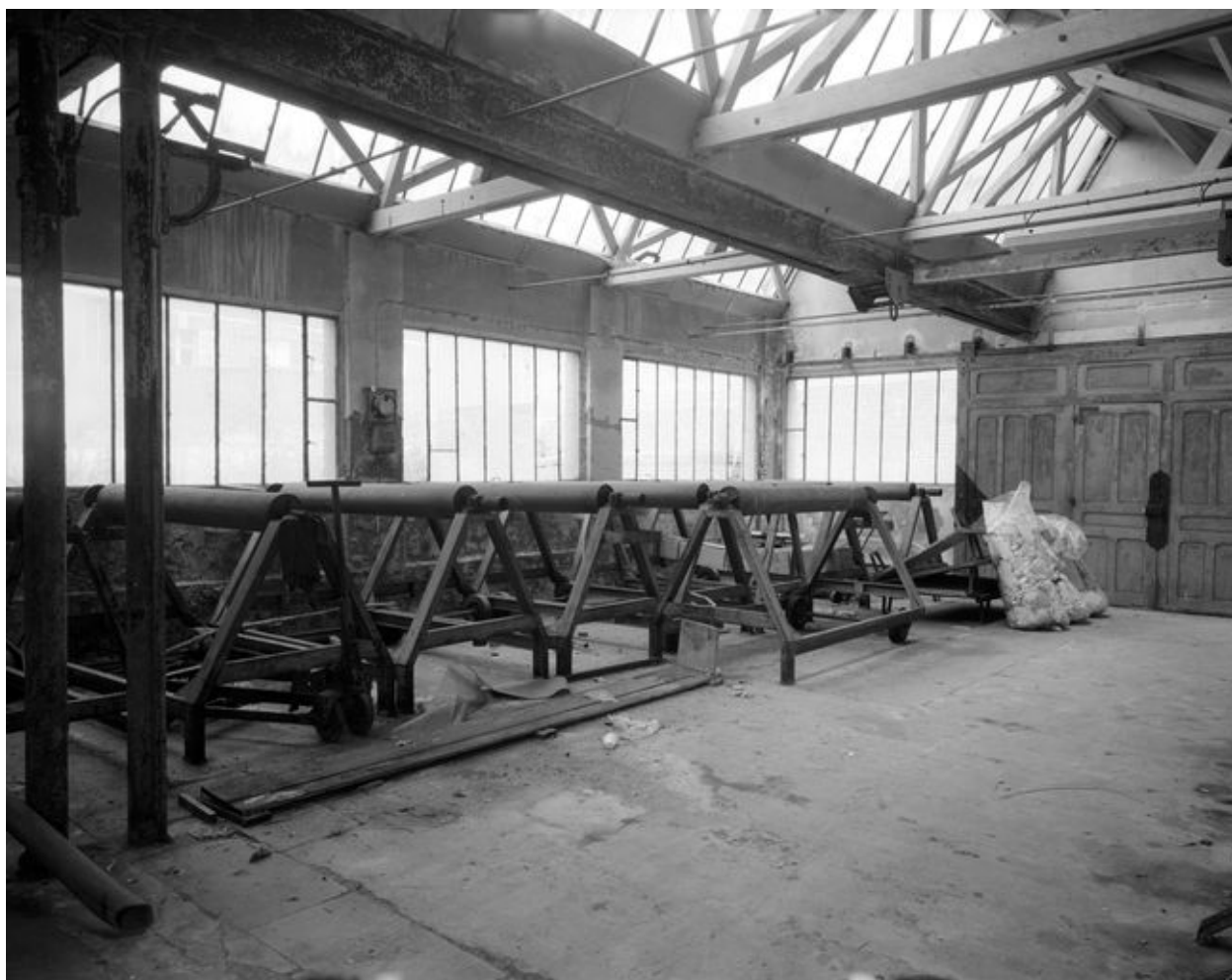
Vue intérieure des anciens ateliers de fabrication.
