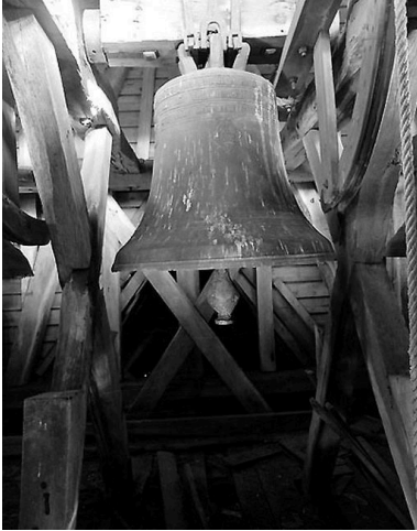
Vue générale. Phot. Laurent Jumel IVR22_19970202189X
