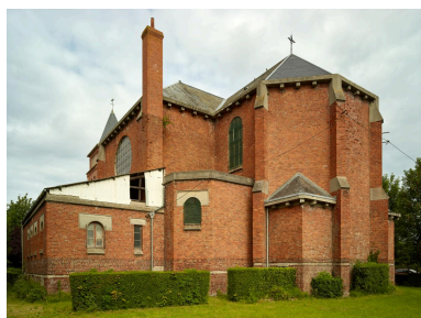
Chevet de l'église. Phot. Pierre Thibaut IVR32_20226200181NUCA
