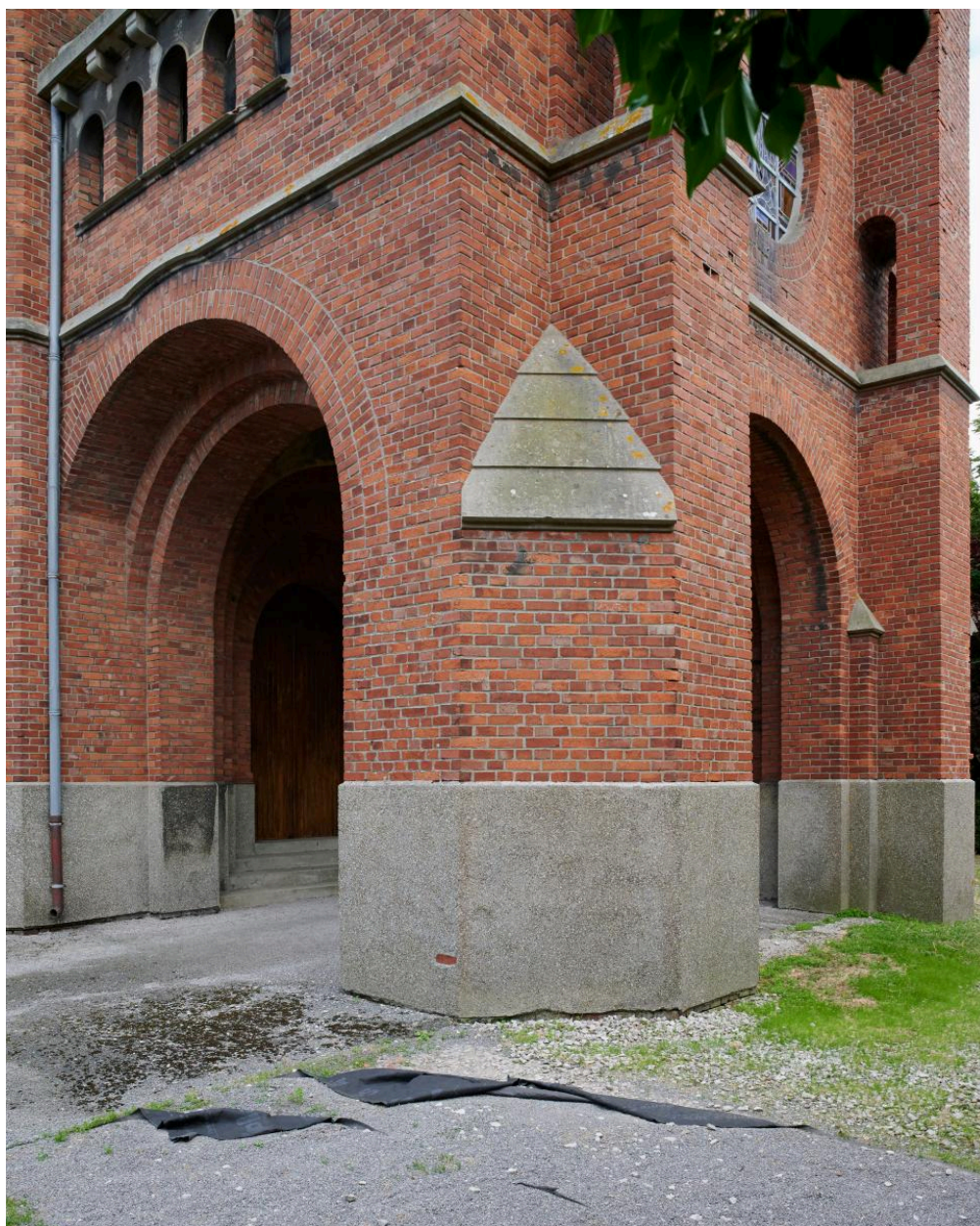
Clocher-porche. Vue depuis le nord-ouest.
