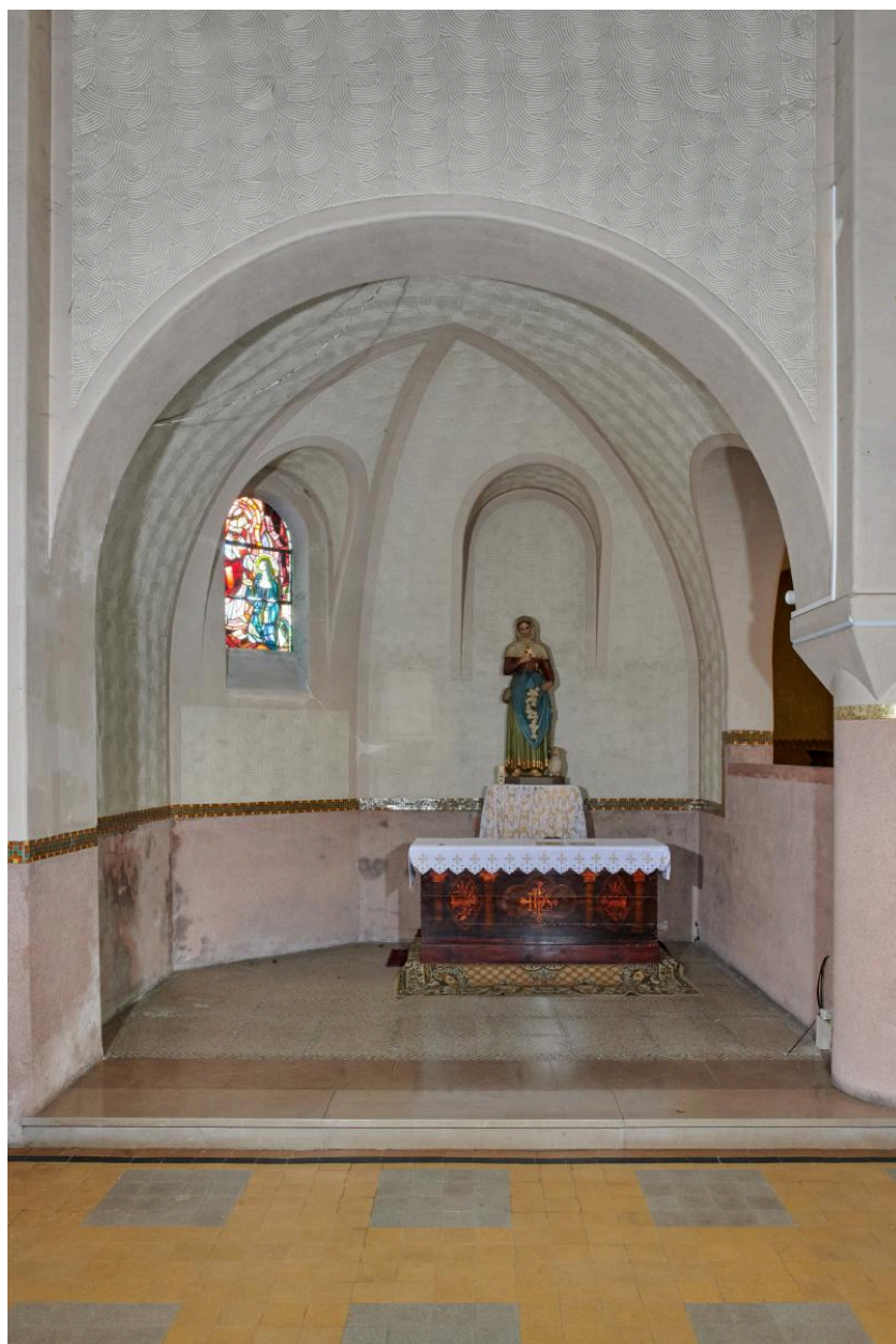
Vue intérieure de la chapelle absidiale nord.
