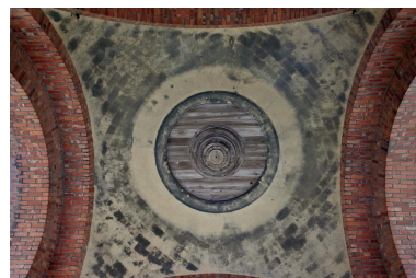
Voûte du porche. Phot. Pierre Thibaut IVR32_20226200250NUCA
