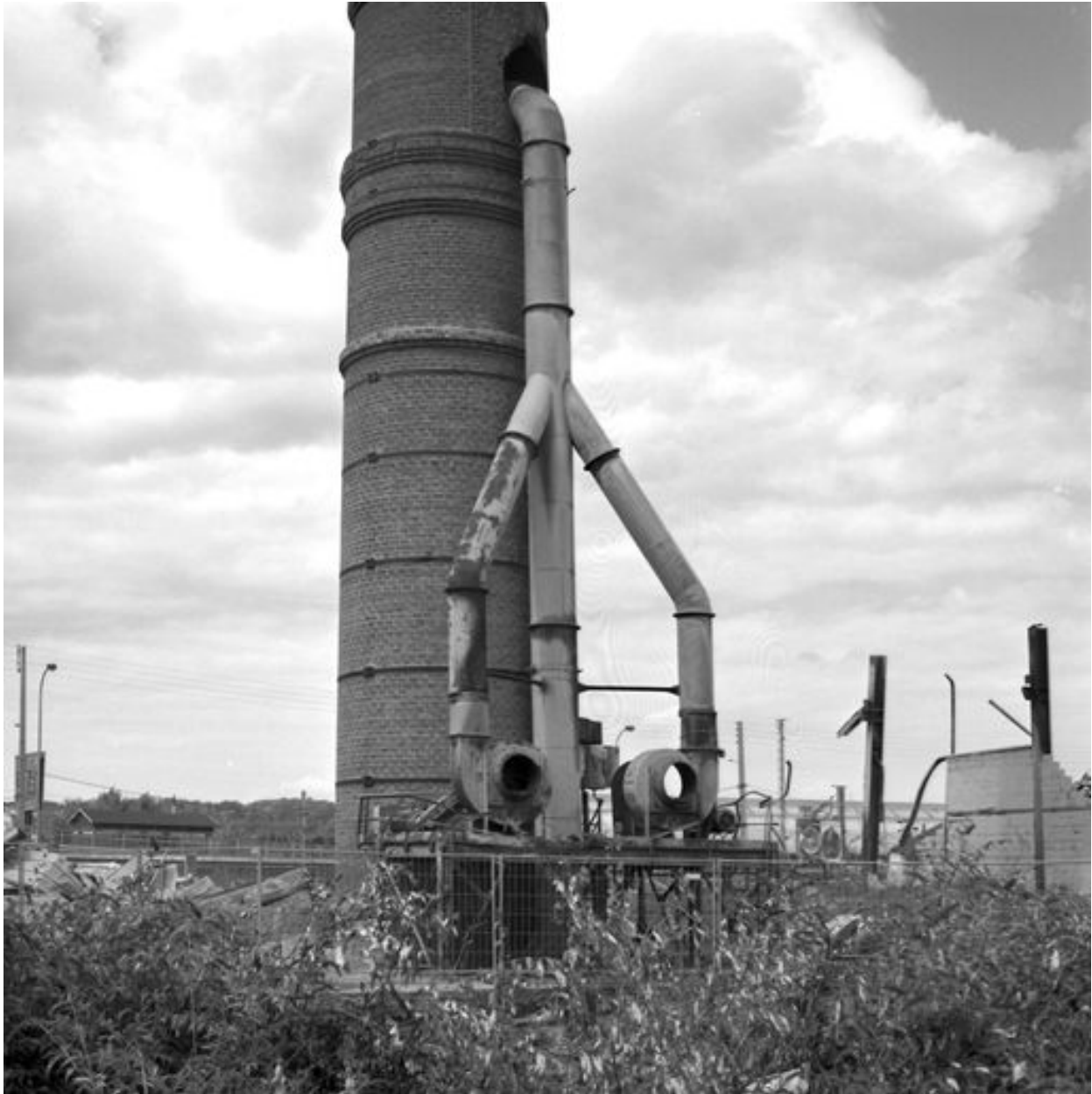
Base de la cheminée en brique attenante aux fours.
