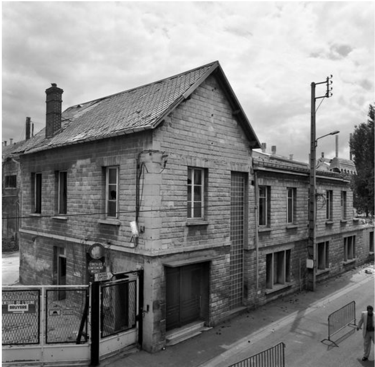
Les bureaux depuis le pont Y, en 1999.
