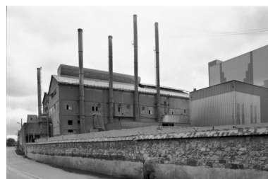
Fours à poussière et fours annexes, en 1992. Phot. Benoît Dufournier IVR22_19926000225Z
