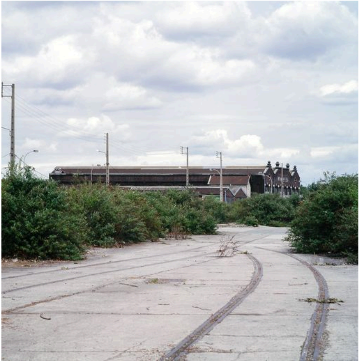
Embranchements ferroviaires et à l'arrière-plan l'ancienne usine de coffres-forts Fichet.
