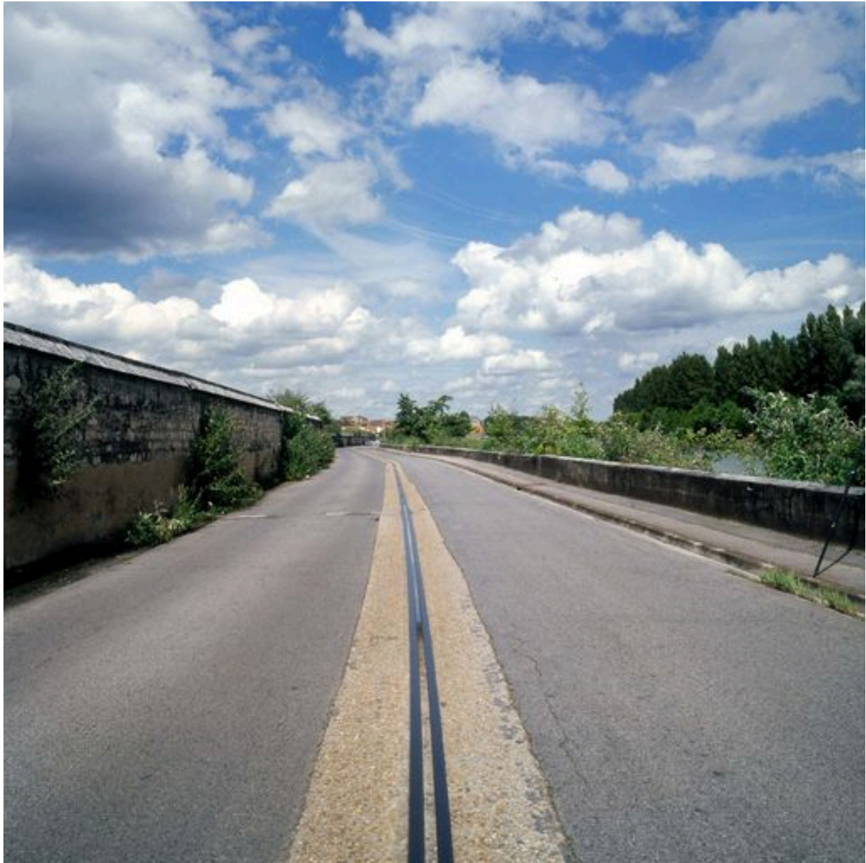
Rails de la grue utilisée par l'usine de la Vieille-Montagne sur le quai d'Aval.
