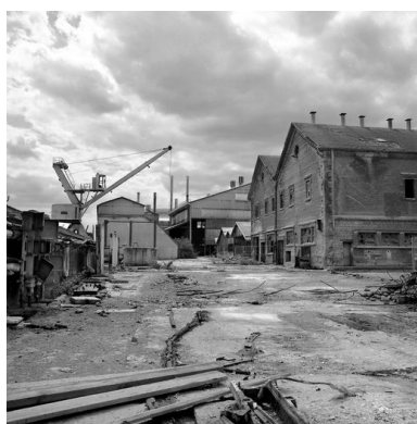
Vue vers l'ouest du bâtiment des chaudières et des fours (à droite), des zones de stockage des minerais et de la grue (à gauche), en 1999. Phot. Thierry Lefébure IVR22_19996000462X
