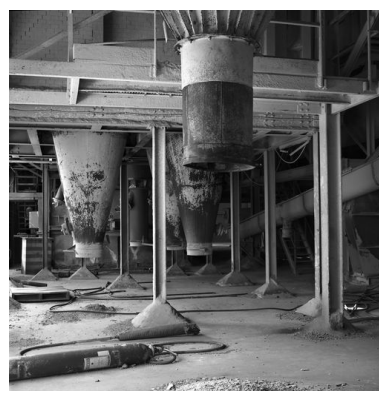
Trémies dans le bâtiment des fours. Phot. Thierry Lefébure IVR22_19996000851X
