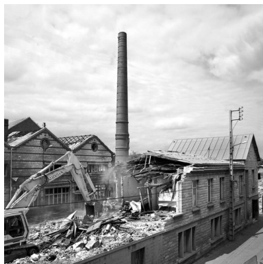
Démolition des bureaux, en 1999. Phot. Thierry Lefébure IVR22_19996000450X
