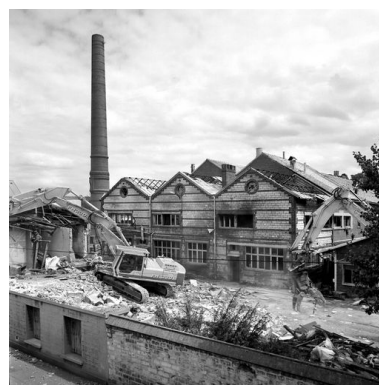
Démolition des bureaux, en 1999. Phot. Thierry Lefébure IVR22_19996000447X
