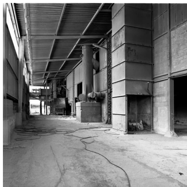
Monte-charge. Phot. Thierry Lefébure IVR22_19996000862X
