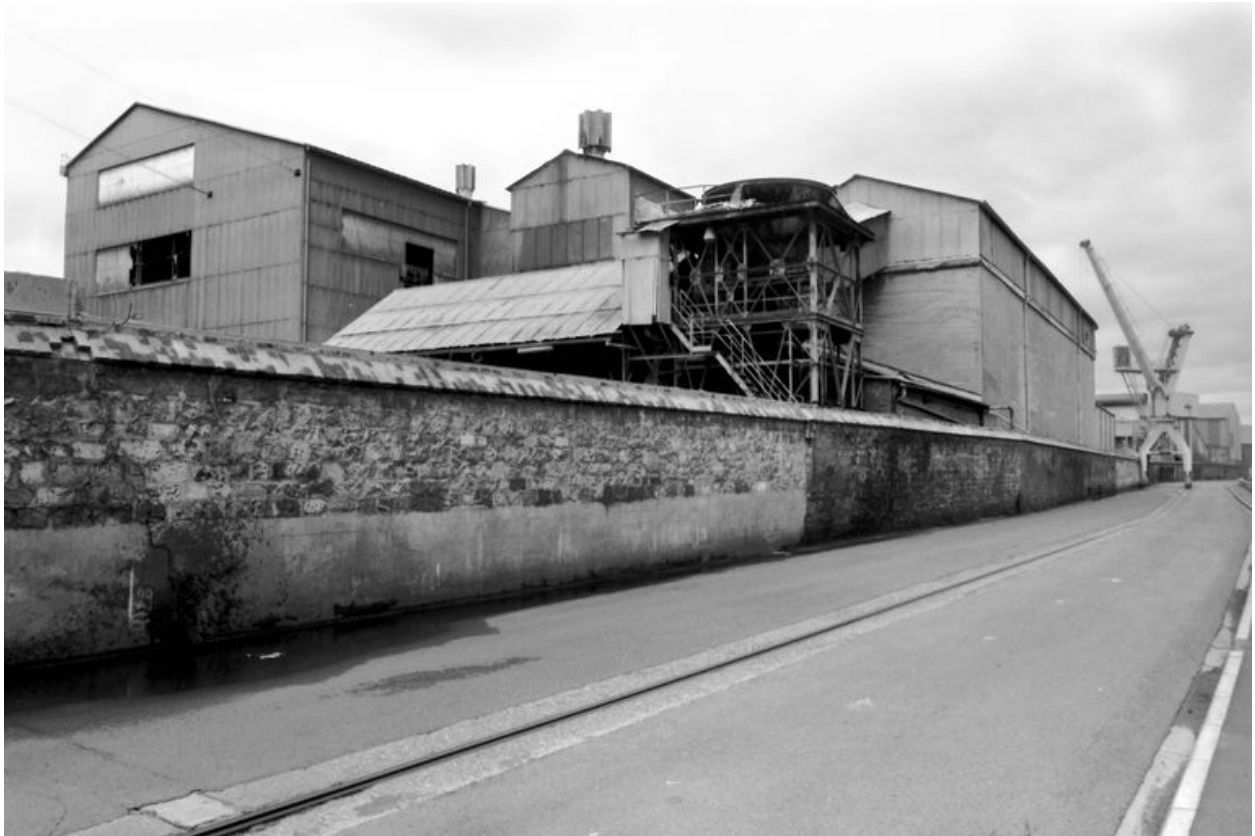
Bâtiments de stockage des minerais et charbons, en 1992.
