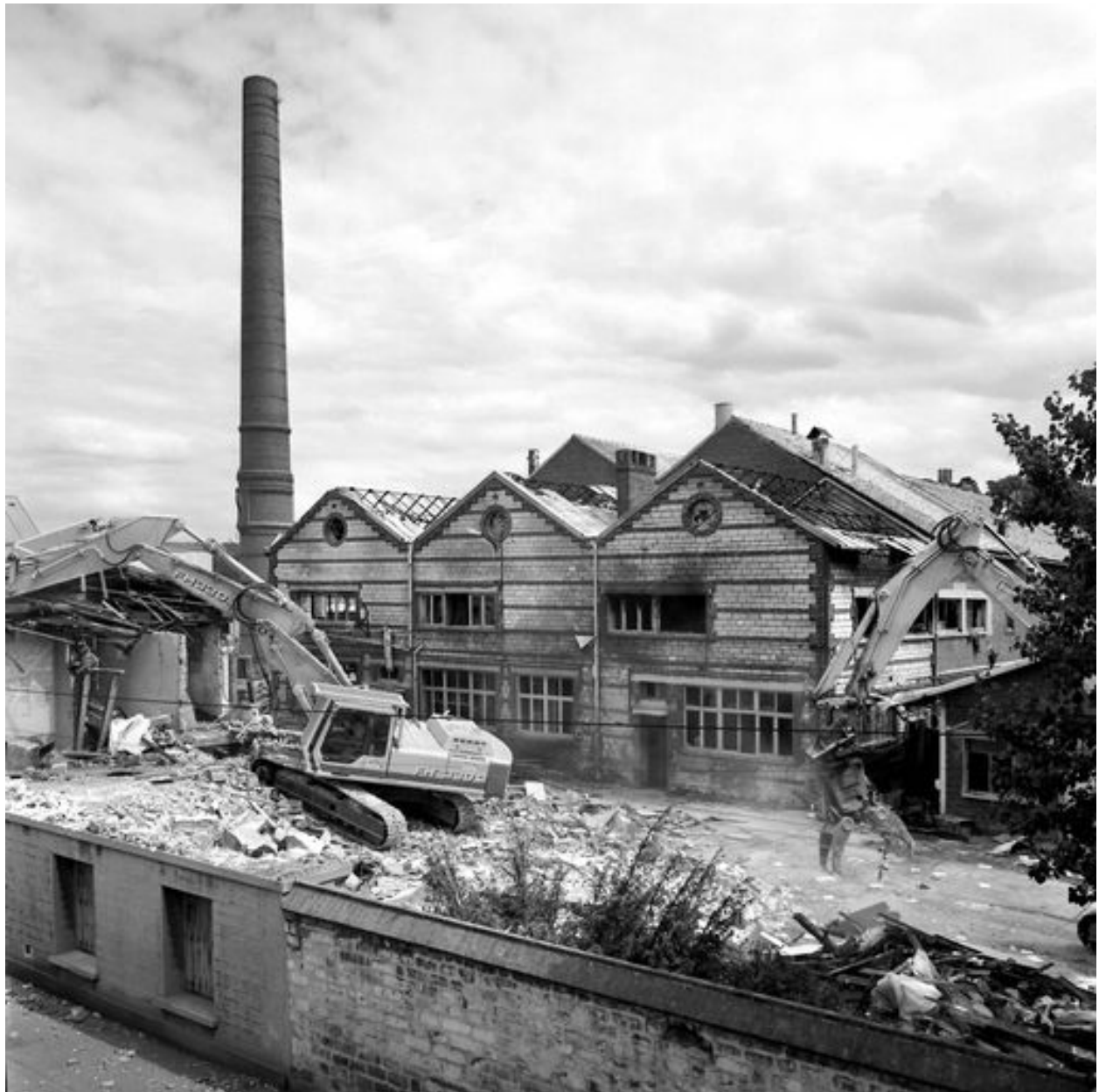
Démolition des bureaux, en 1999.
