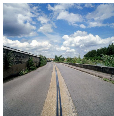
Rails de la grue utilisée par l'usine de la Vieille-Montagne sur le quai d'Aval. Phot. Thierry Lefébure IVR22_20076000094XA
