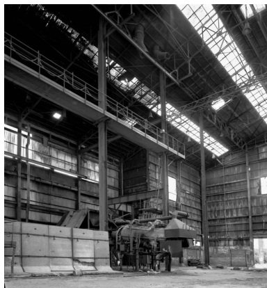
Intérieur du bâtiment abritant les fours. Phot. Thierry Lefébure IVR22_19996000466X
