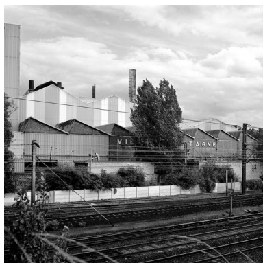
La Vieille-Montagne avant sa démolition vue du pont Y. Phot. Thierry Lefébure IVR22_19996000441X
