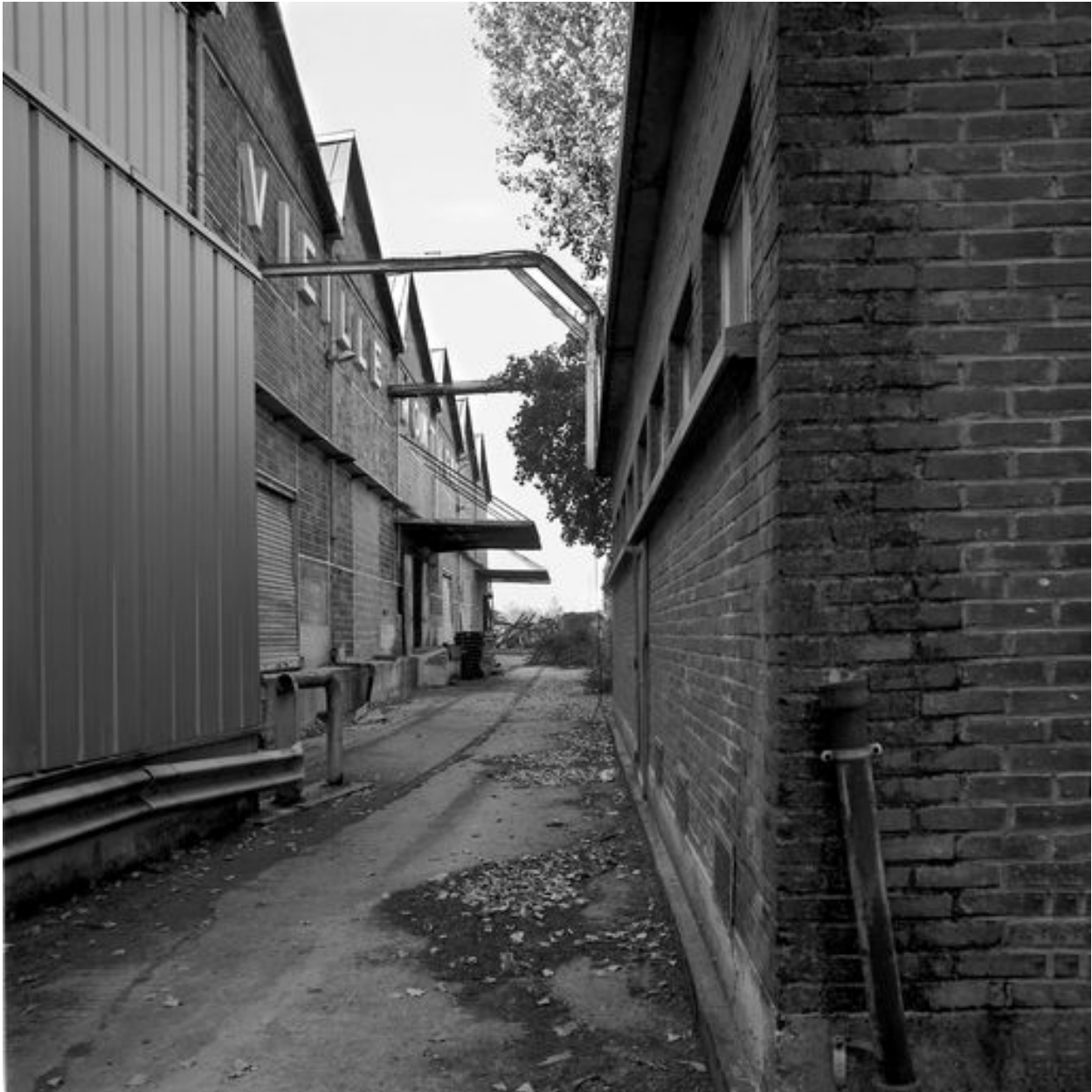
Quais de chargement et de déchargement.
