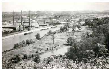
Le site de la Vieille-Montagne depuis la rive gauche de l'Oise. Phot. Clarisse Lorieux IVR22_20066005210NUCAB
