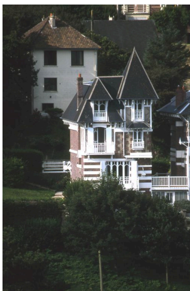
Elévation côté mer. Phot. Marie-Laure Monnehay-Vulliet IVR22_20048000177ZA
