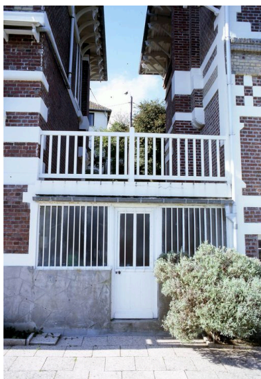
Extension latérale tardive. Phot. Marie-Laure Monnehay-Vulliet IVR22_20048000196XA
