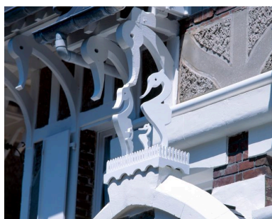
Détail du décor en menuiserie. Phot. Marie-Laure Monnehay-Vulliet IVR22_20038000687XA
