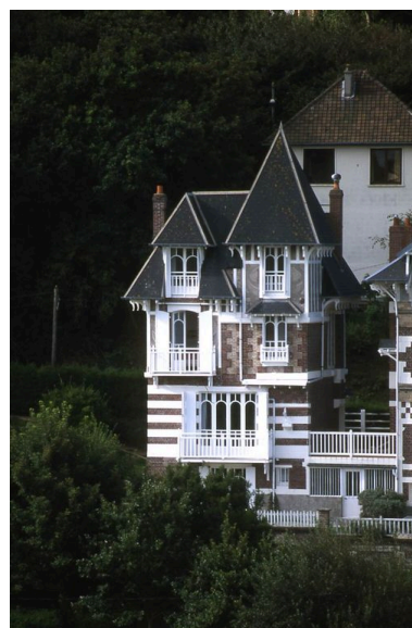
Elévation côté mer. Phot. Marie-Laure Monnehay-Vulliet IVR22_20048000178ZA
