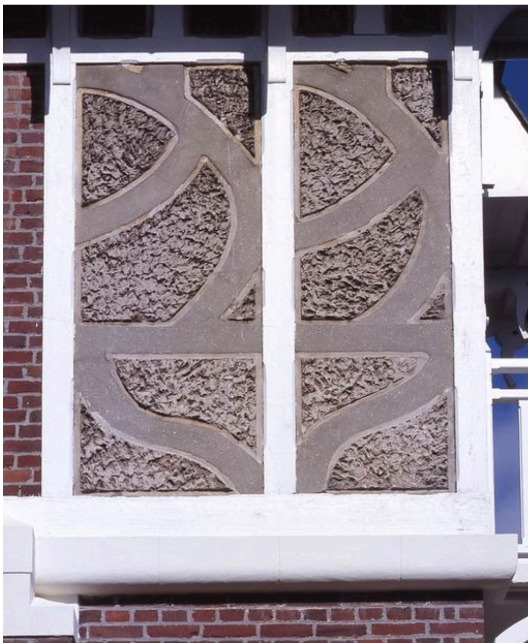
Détail du faux pan de bois enduit.
