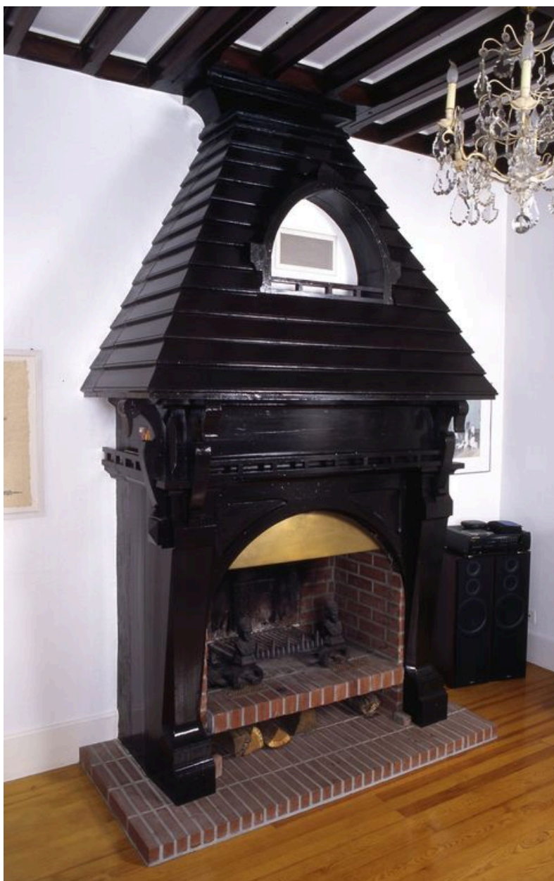
Cheminée du 'hall' ou pièce de réception.
