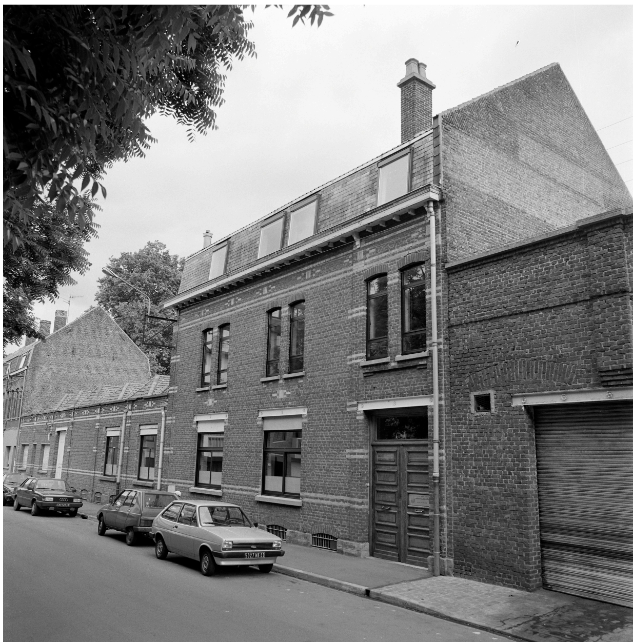
Bureaux et atelier de fabrication, rue Jacquard.
