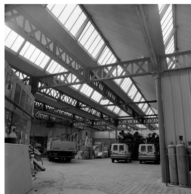
Atelier de fabrication rue Jacquard, vue intérieure. Phot. Philippe Dapvril IVR31_19885901372X
