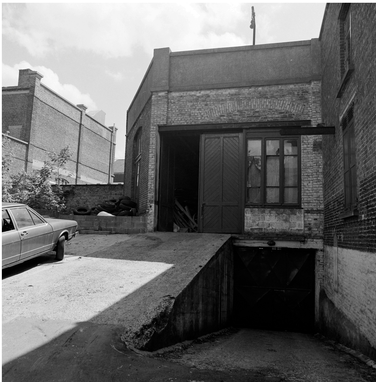
Rampe d'accès au sous-sol.
