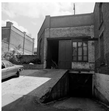
Rampe d'accès au sous-sol. Phot. Philippe Dapvril IVR31_19885901176X
