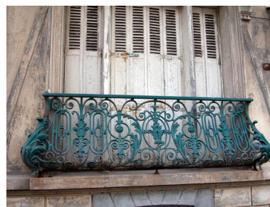
Détail du décor de fonte du garde-corps de balconnet de l'habitation sans appellation (partie droite de la maison). Phot. Elisabeth Justome IVR22_20048001397NUCA
