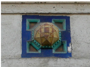
Détail du cabochon de céramique situé sur le linteau de l'entrée, logement dit Heures Claires. Phot. Elisabeth Justome IVR22_20058003175NUCA
