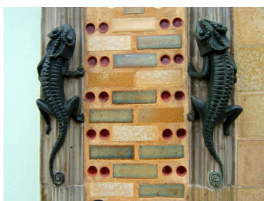
Détails des salamandres ornant la façade sur rue. Phot. Magalie Thueux IVR22_20066090077NUCA
