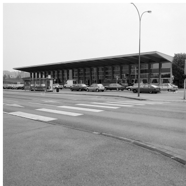
Vue d'angle nord-ouest. Phot. Philippe Dapvril IVR31_19946200585X
