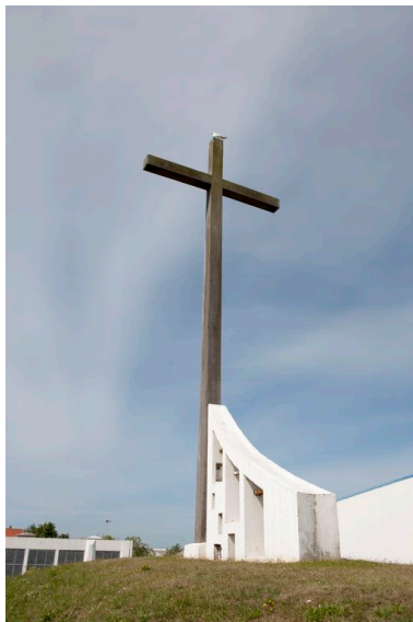
Détail du campanile. Phot. Hubert Bouvet IVR31_20156200152NUCA
