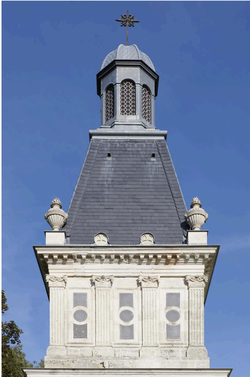
Clocher-porche. Vue rapprochée des pilastres cannelés, des chapiteaux d'angle, des plaques en pierre bleue ; des pots à feu ; du campanile en bois couvert de feuilles de zinc.
