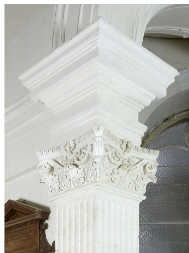
Vue de détail d'un chapiteau de l'abside. Phot. Delphine Volto-Jourdan IVR32_20246200035NUCA
