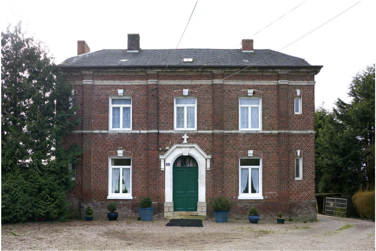
Maison du chapelain. Vue prise depuis l'ancienne chaussée Brunehaut.
