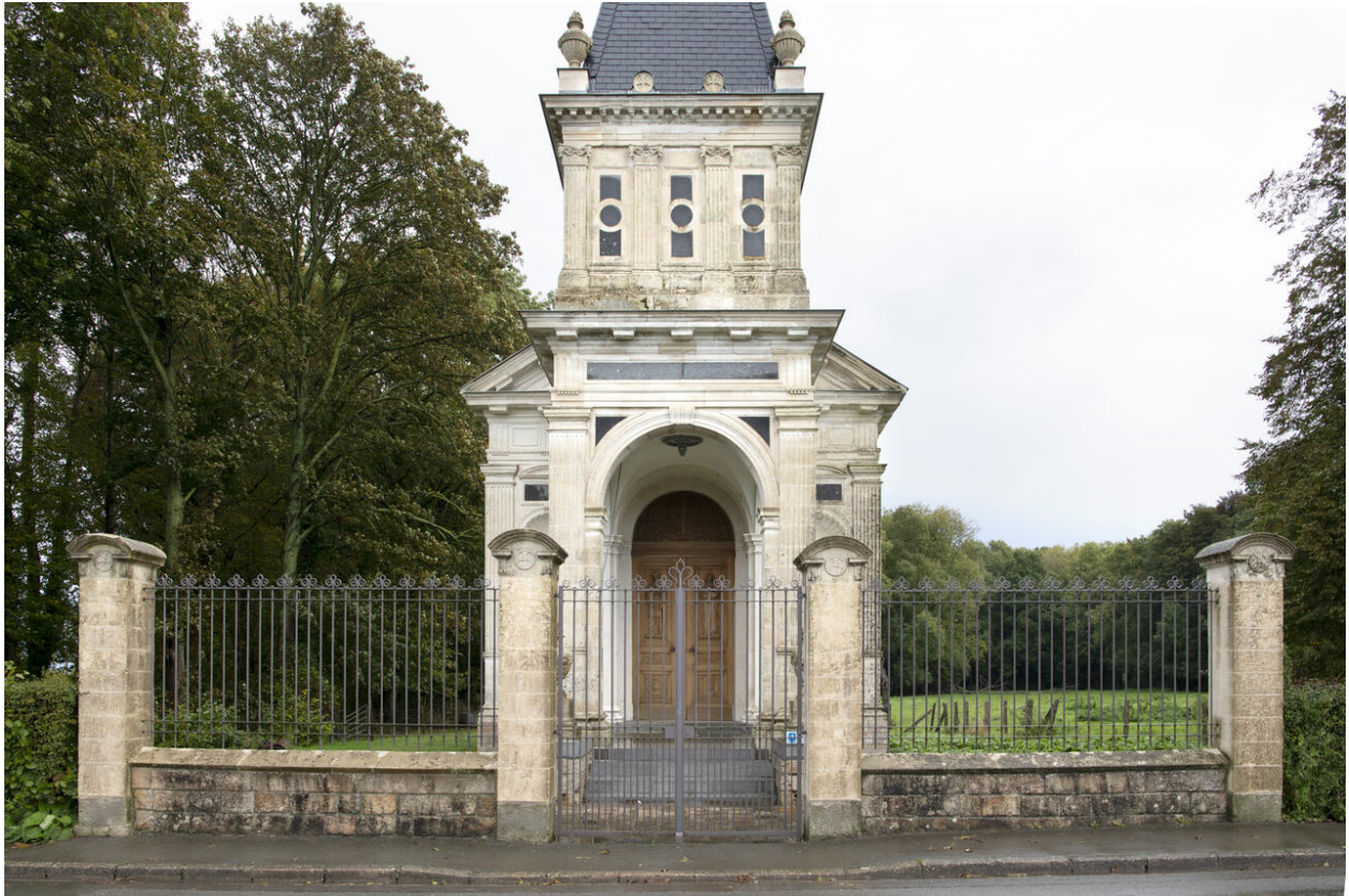
Portail et mur de clôture surmonté d'une grille, à l'alignement de l'ancienne chaussée Brunehaut.
