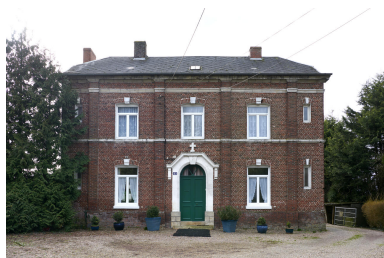
Maison du chapelain. Vue prise depuis l'ancienne chaussée Brunehaut. Phot. Delphine Volto-Jourdan IVR32_20246200030NUCA
