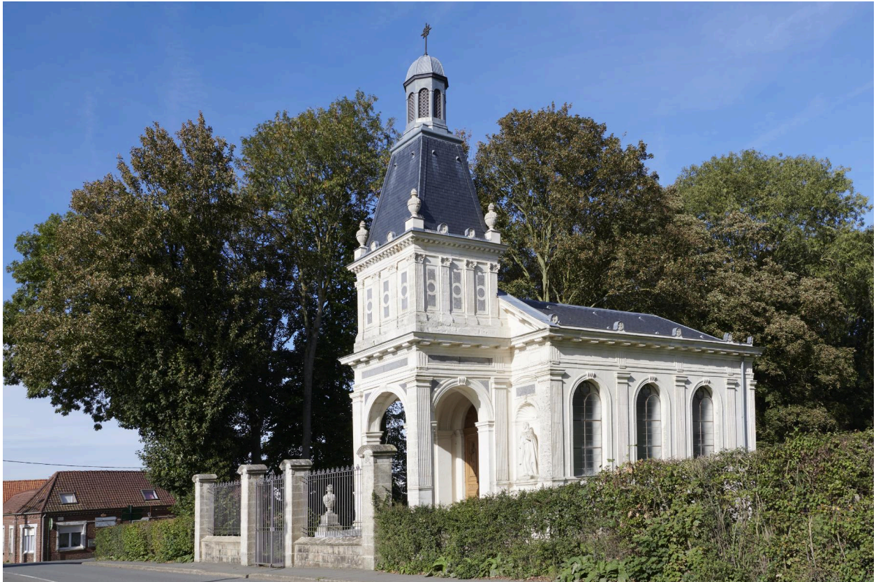
Vue générale de la chapelle prise depuis la chaussée Brunehaut en venant de Cauchy-à-la-Tour.
