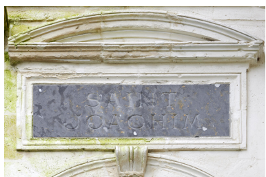
Inscription SAINT JOACHIM sur pierre bleue dans un encadrement en pierre calcaire sous un fronton cintré également en pierre calcaire. Phot. Delphine Volto-Jourdan IVR32_20246200012NUCA
