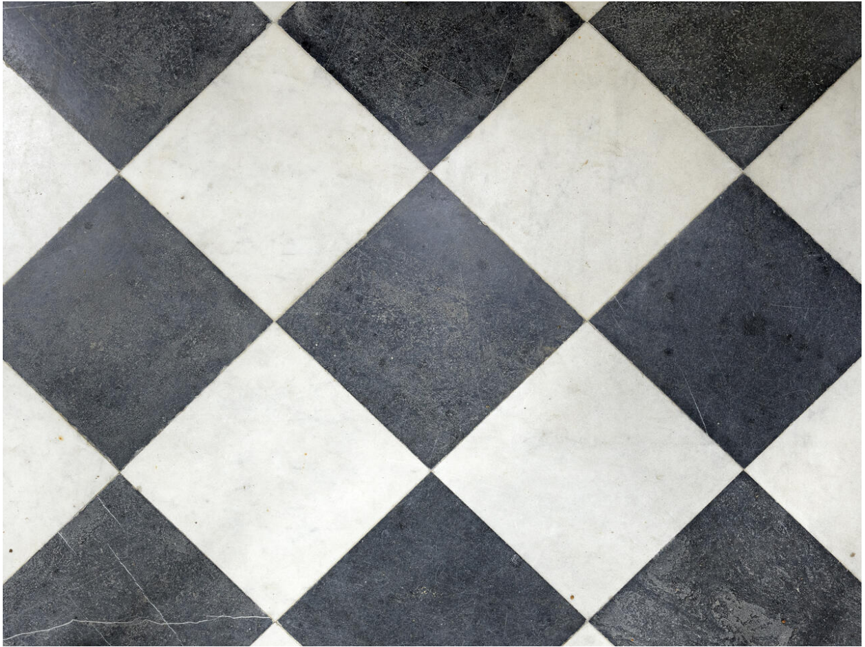
Vue de détail du dallage en marbre (motif en damier) de la nef.
