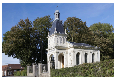
Vue générale de la chapelle prise depuis la chaussée Brunehaut en venant de Cauchy-à-la-Tour. Phot. Delphine Volto-Jourdan IVR32_20236200921NUCA
