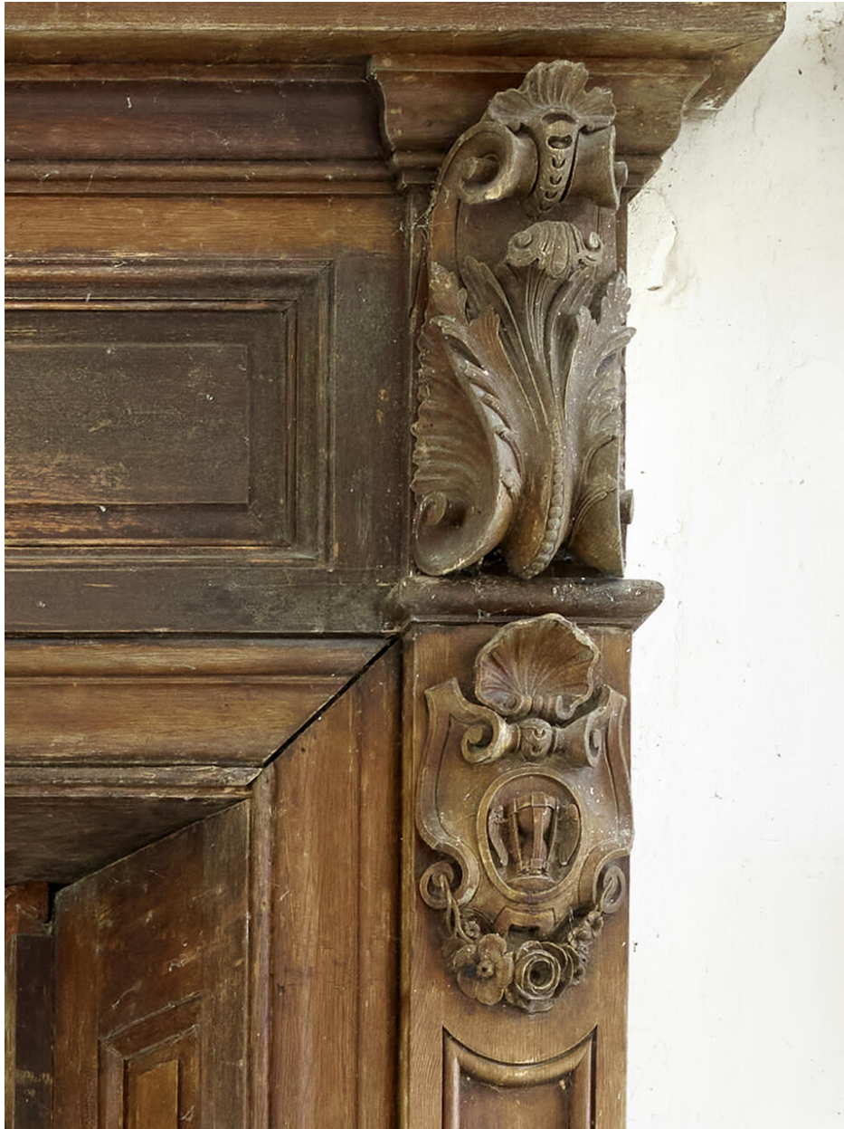
Vue de détail de la partie supérieure d'un chambranle de la porte d'entrée.
