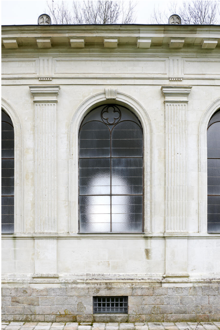
Vue de détail de la travée centrale du mur-gouttereau nord-ouest.
