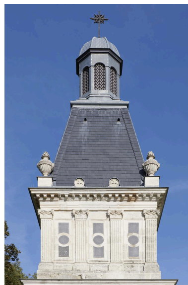
Clocher-porche. Vue rapprochée des pilastres cannelés, des chapiteaux d'angle, des plaques en pierre bleue ; des pots à feu ; du campanile en bois couvert de feuilles de zinc. Phot. Delphine Volto-Jourdan IVR32_20236200920NUCA
