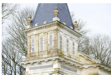
Clocher-porche. Vue rapprochée des pilastres cannelés, des chapiteaux d'angle, des plaques en pierre bleue ; des pots à feu. Phot. Delphine Volto-Jourdan IVR32_20246200029NUCA
