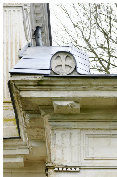
Élévation nord-ouest. Vue de détail de l'entablement, de la corniche et d'un antéfixe. Phot. Delphine Volto-Jourdan IVR32_20246200016NUCA
