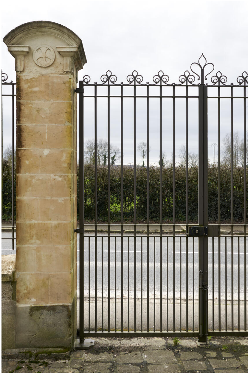
Vue de détail d'une pile de clôture prise depuis la chapelle.
