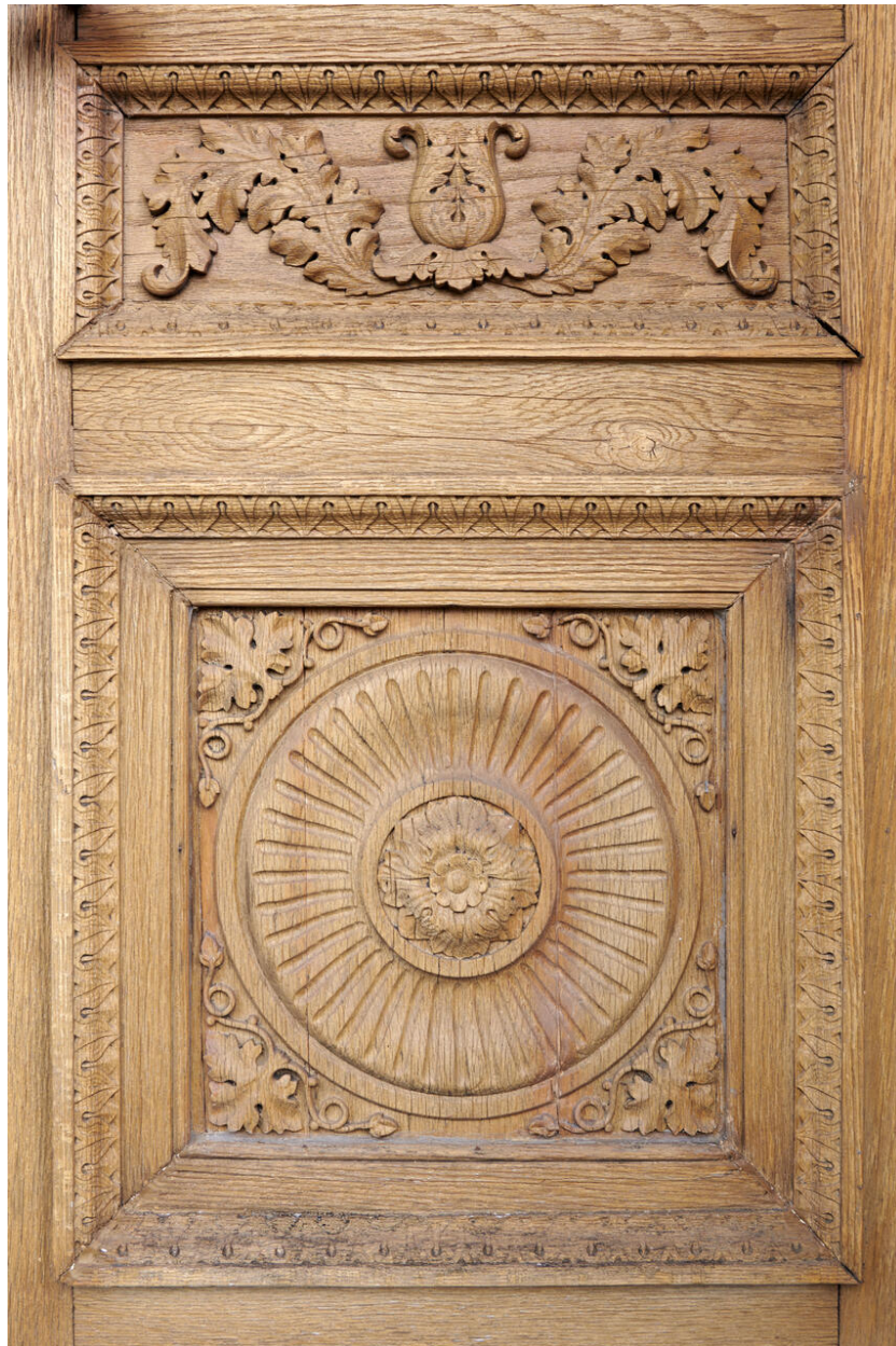
Détail des moulurations à grand cadre des parties centrale et inférieure d'un vantail de la porte d'entrée (vue extérieure).
