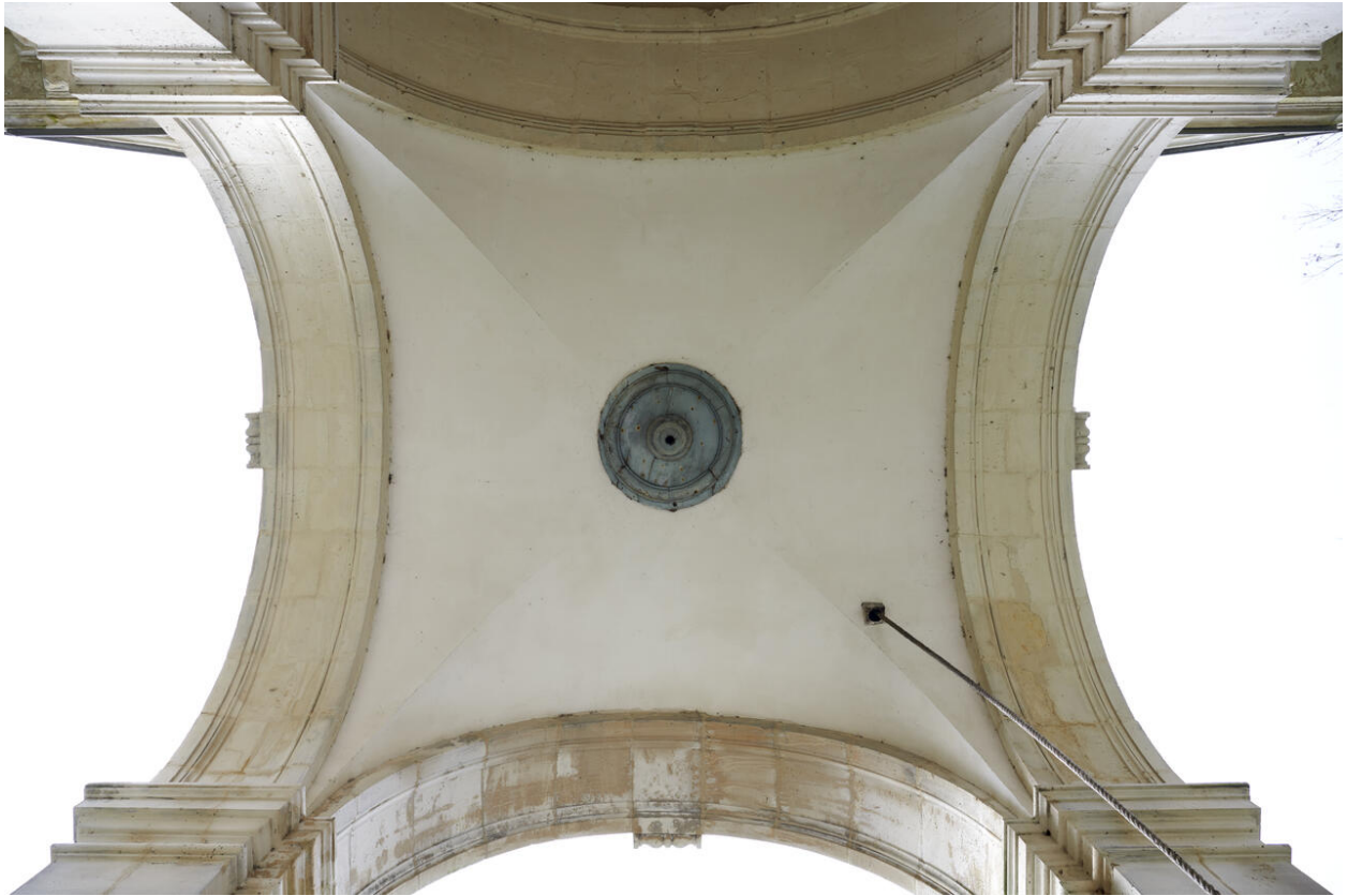
Vue des voûtains de la fausse voûte en plâtre de la loggia (avec au centre la clef annulaire amovible).
