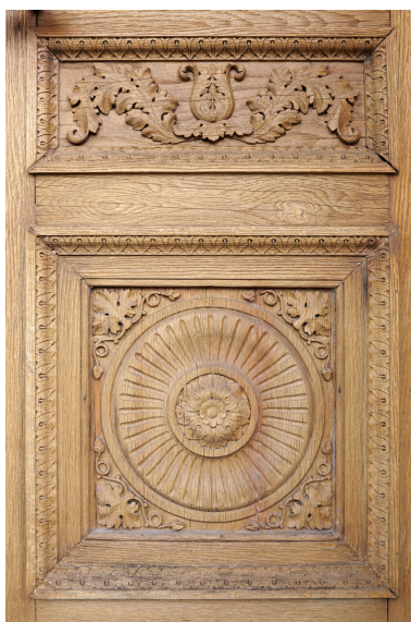
Détail des moulurations à grand cadre des parties centrale et inférieure d'un vantail de la porte d'entrée (vue extérieure). Phot. Delphine Volto-Jourdan IVR32_20246200006NUCA
