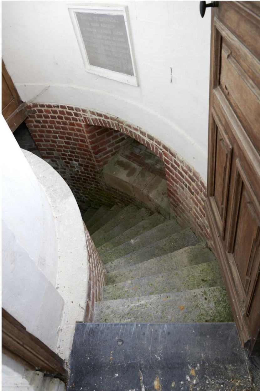
Vue de détail de l'escalier permettant l'accès à la crypte.
