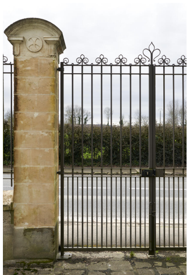
Vue de détail d'une pile de clôture prise depuis la chapelle. Phot. Delphine Volto-Jourdan IVR32_20246200010NUCA
