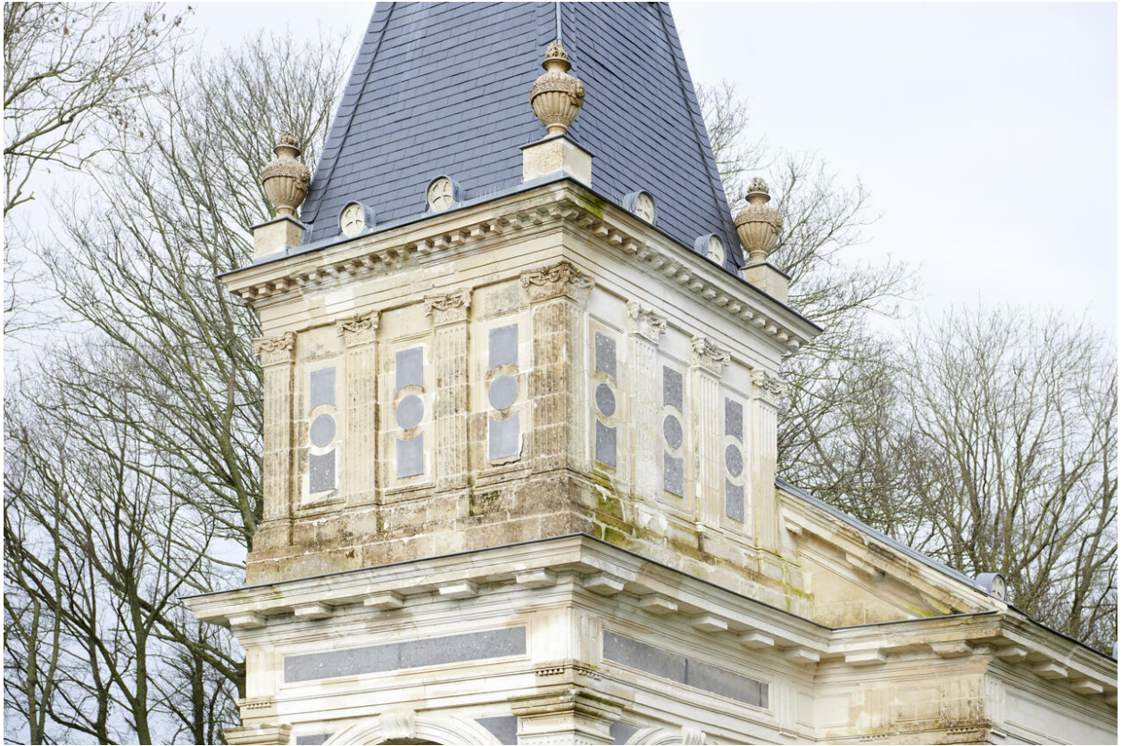
Clocher-porche. Vue rapprochée des pilastres cannelés, des chapiteaux d'angle, des plaques en pierre bleue ; des pots à feu.
