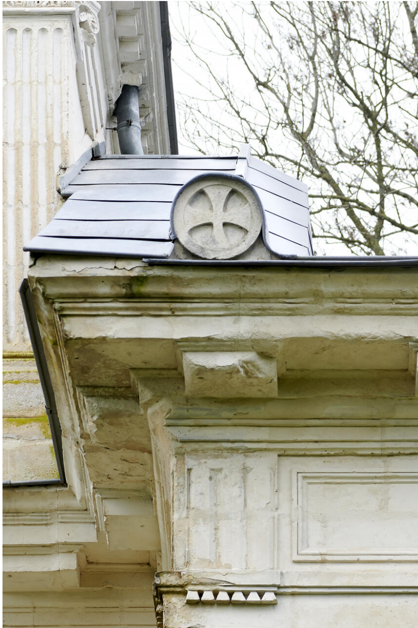
Élévation nord-ouest. Vue de détail de l'entablement, de la corniche et d'un antéfixe.
