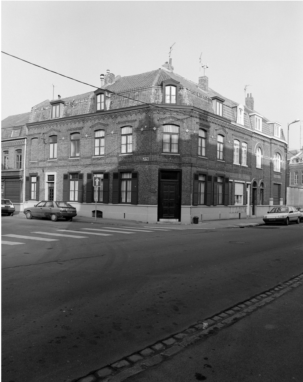
Vue générale sur angle.
