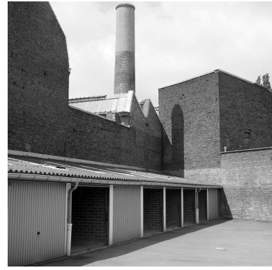
Élévation postérieure, atelier de fabrication. Phot. Philippe Dapvril IVR31_19885901198X
