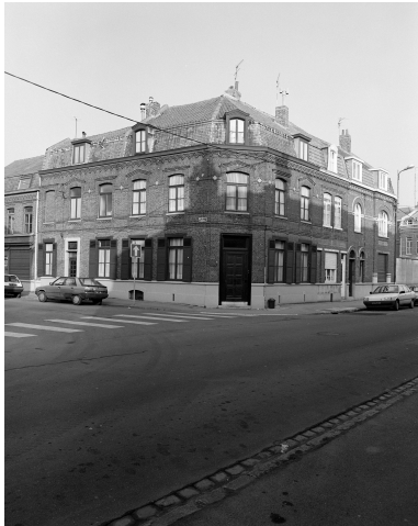
Vue générale sur angle. Phot. Olivier Marlard IVR31_19915900095XA
