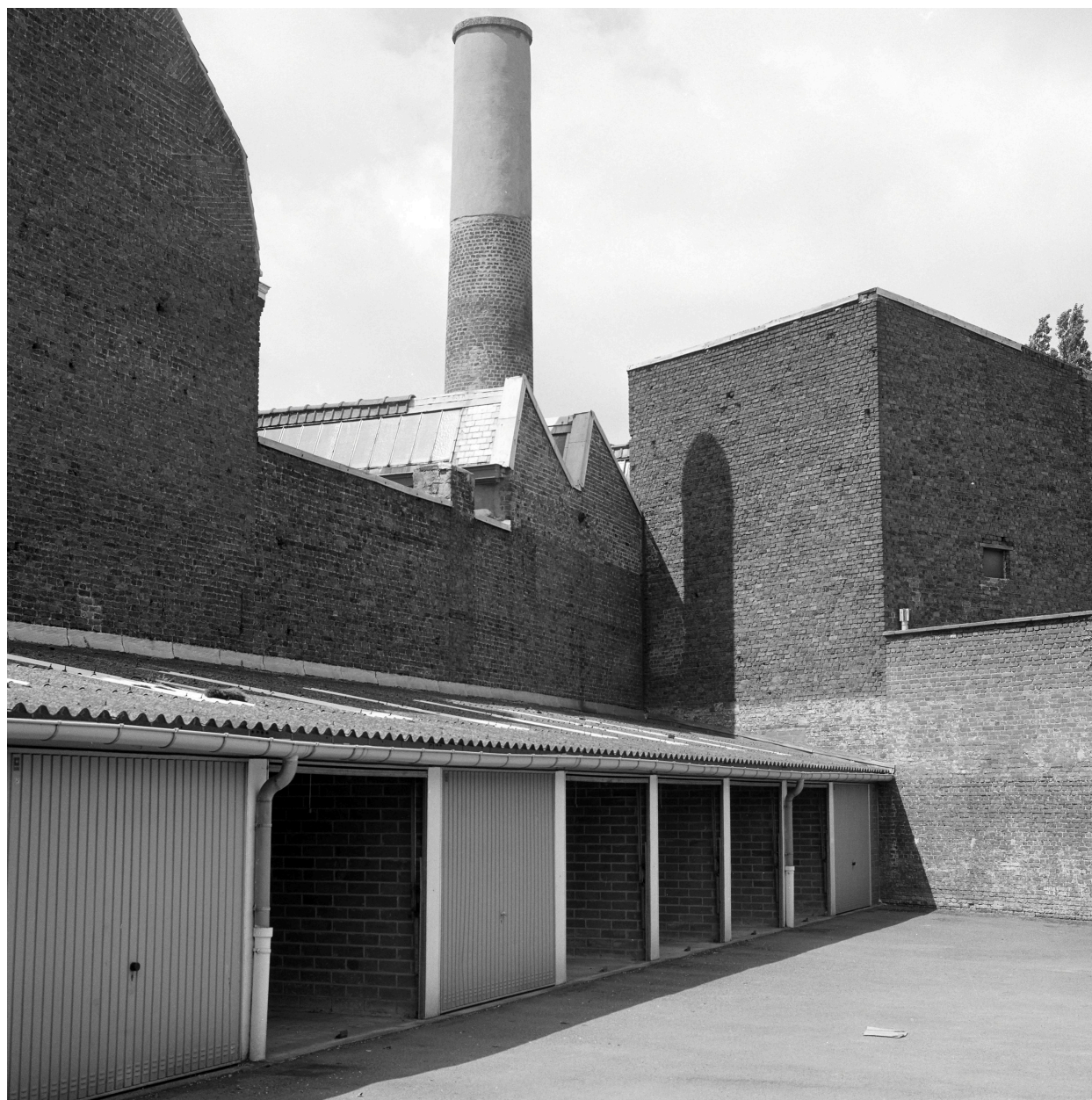
Élévation postérieure, atelier de fabrication.
