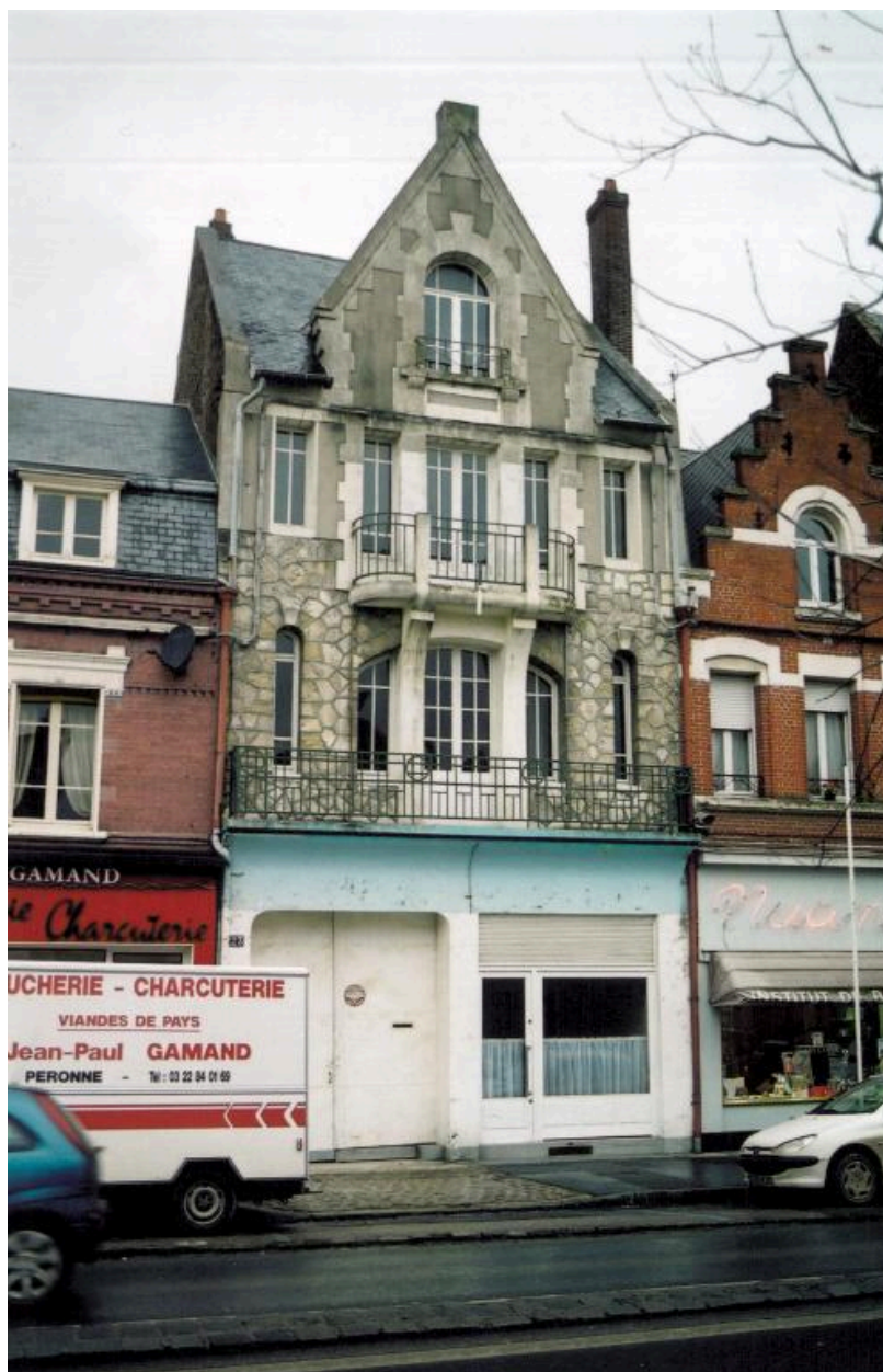
Maison, 23 rue Saint-Sauveur (B 339), reconstruite vers 1925.
