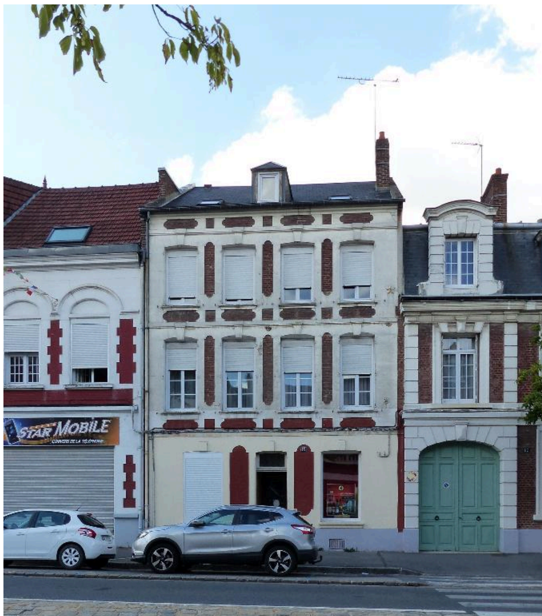
Maison, 15 rue Saint-Sauveur (B 333), reconstruite vers 1921.
