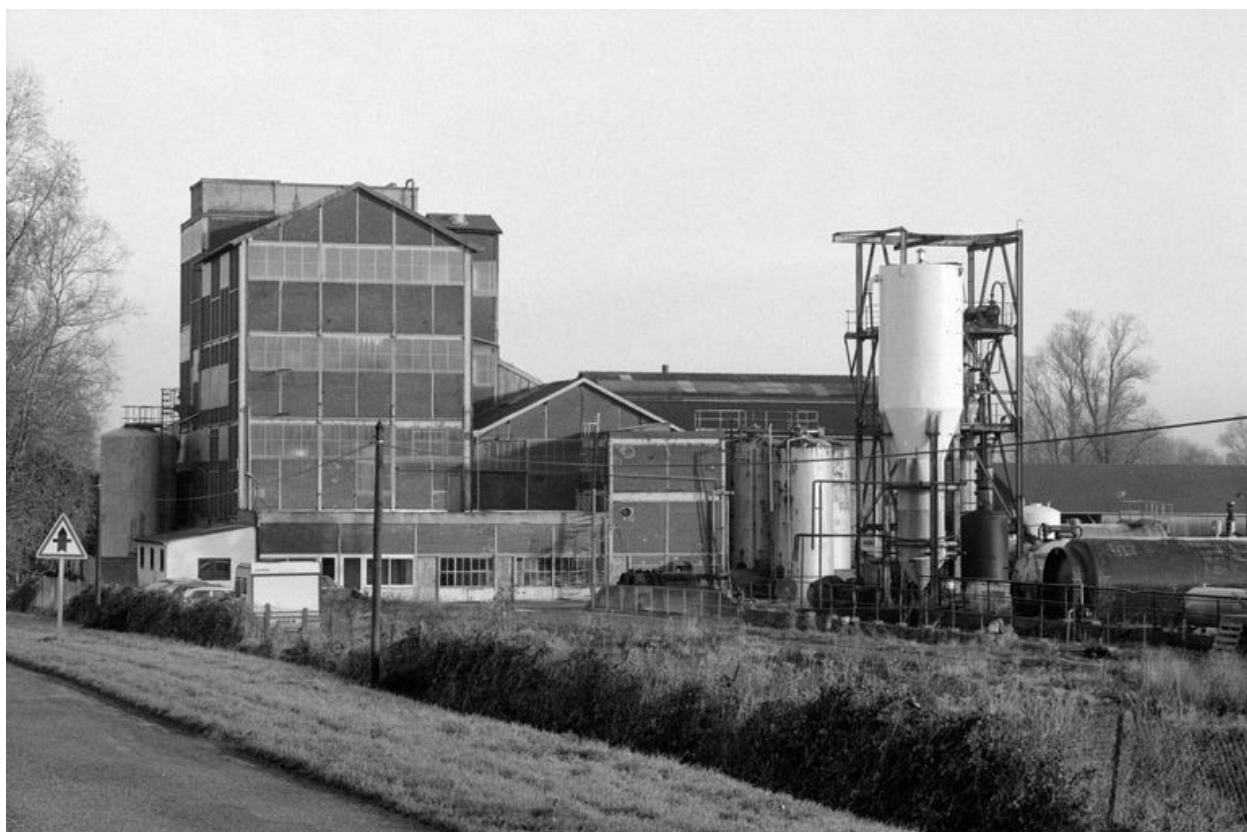
Vue d'ensemble, flanc sud.
