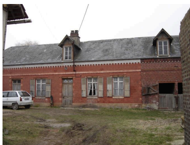
Vue du logis depuis la cour. Phot. Inès Guérin IVR22_20058005022NUCA
