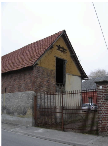
Vue partielle de la grange sur rue. Phot. Inès Guérin
