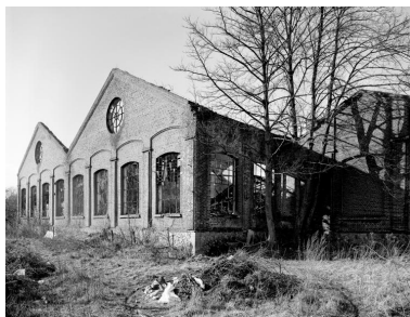
Sous-station électrique. Élévation sur la Sambre. Phot. Thierry Petitberghien IVR31_19955900196V
