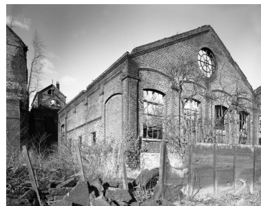
Sous-station électrique. Élévation sur la Sambre. À l'arrière-plan, à gauche, la conciergerie. Phot. Thierry Petitberghien IVR31_19955900195V
