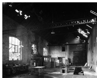
Atelier de réparation, vue intérieure. Phot. Thierry Petitberghien IVR31_19955900201V
