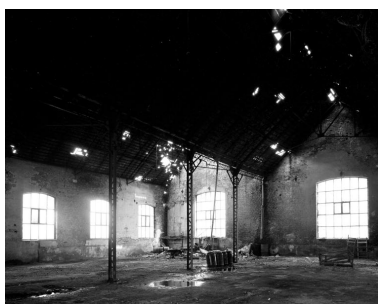
Remise ferroviaire, vue intérieure. Phot. Thierry Petitberghien IVR31_19955900200V
