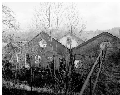
Sous-station électrique. Vue prise depuis la conciergerie. Phot. Thierry Petitberghien IVR31_19955900197V
