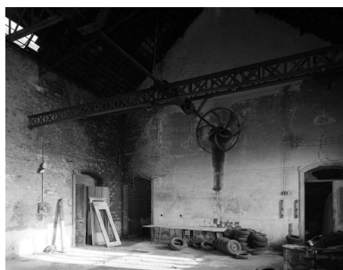
Atelier de réparation, vue intérieure. Phot. Thierry Petitberghien IVR31_19955900202V
