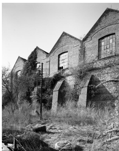
Remise ferroviaire et contreforts. Élévation postérieure, sur la Sambre. Phot. Thierry Petitberghien IVR31_19955900198V
