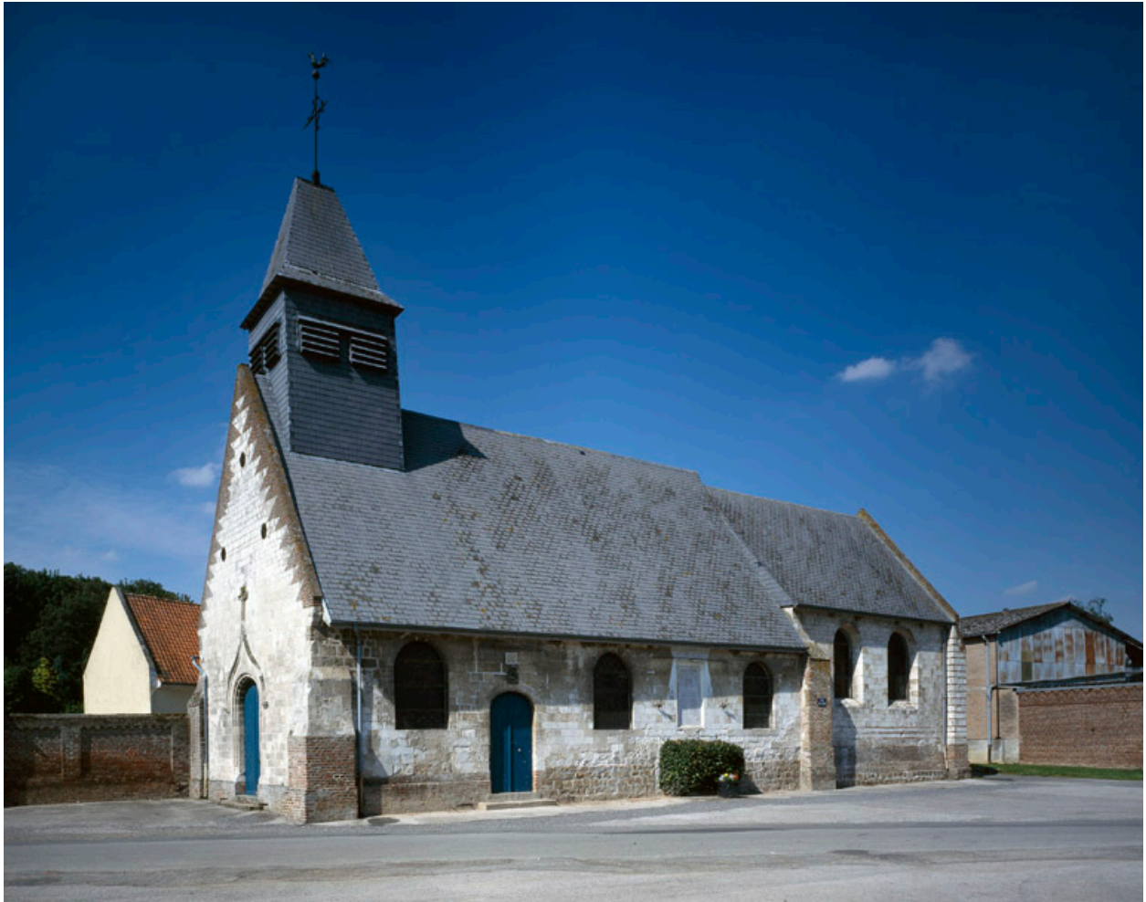
Vue générale, depuis le sud-ouest.
