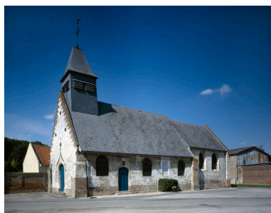
Vue générale, depuis le sud-ouest.
