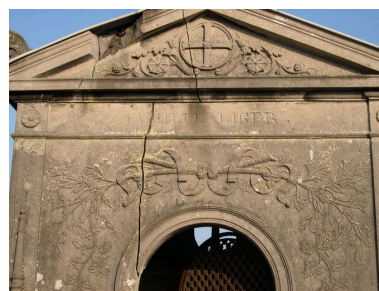
Vue de détail sur le fronton. Phot. Isabelle Barbedor IVR22_20048010809NUCA
