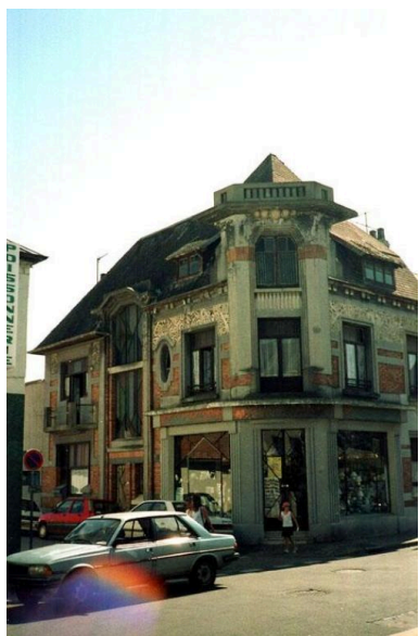
Vue générale en 1996. Phot. Richard Klein IVR31_19966201534ZE
