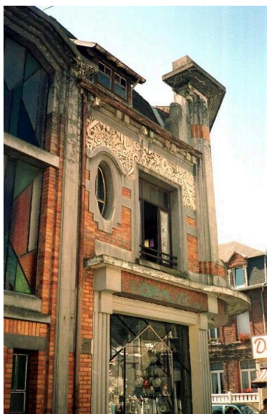
Elévation latérale, en 1996. Phot. Richard Klein IVR31_19966201535ZE
