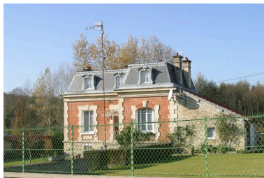
Vue générale de la façade principale, de face.
