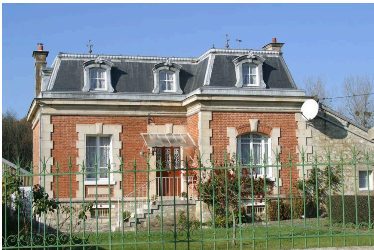
Vue générale de la façade principale.
