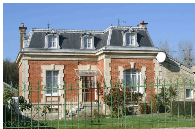
Vue générale de la façade principale.
