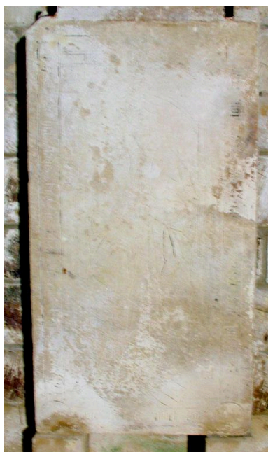
Vue d'une dalle funéraire. Phot. Frédéric Fournis IVR22_20070200193NUC1A
