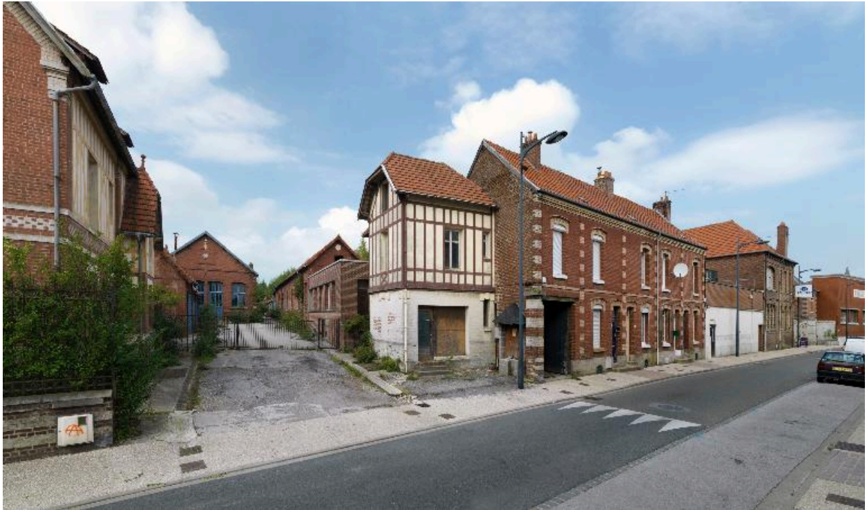
Vue de l'entrée de l'ancienne usine Caron-Lenel ainsi que de la conciergerie.
