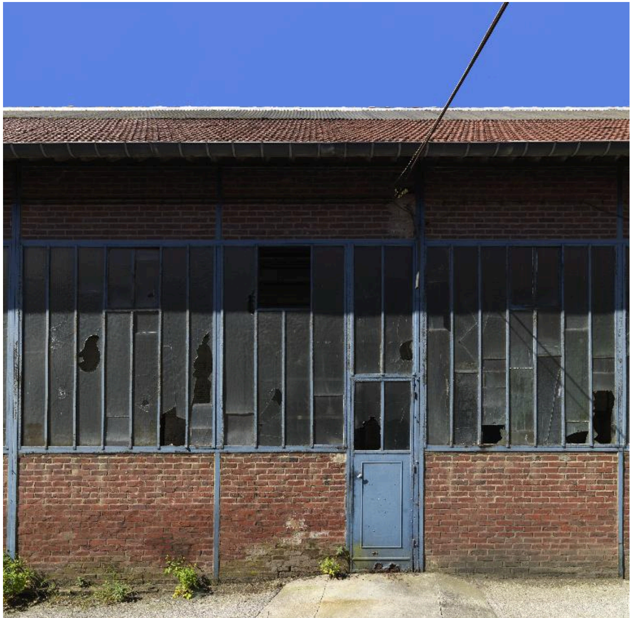
Détail des ouvertures de l'atelier de fabrication.
