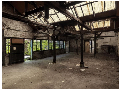
Ancien atelier de fabrication secondaire. Phot. Thierry Lefébure IVR22_20158000400NUC2A
