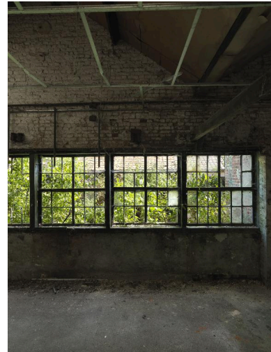
Ouvertures à guillotine de l'ancien atelier de fabrication secondaire. Phot. Thierry Lefébure IVR22_20158000402NUC2A
