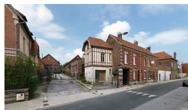
Vue de l'entrée de l'ancienne usine Caron-Lenel ainsi que de la conciergerie. Phot. Thierry Lefébure IVR22_20148000415NUC2AQ
