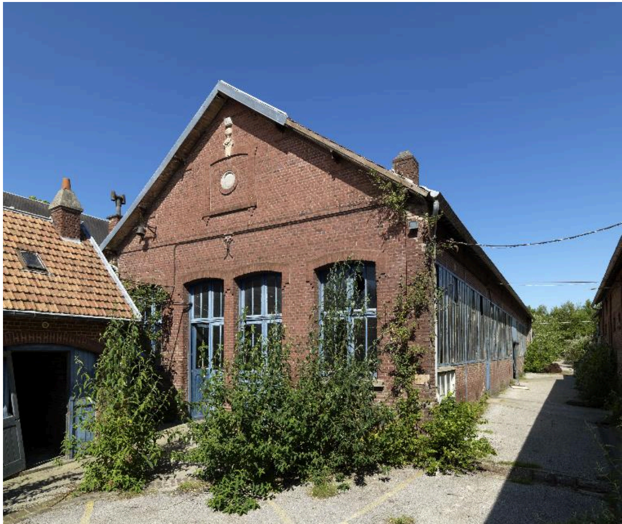
Ancien atelier de fabrication.
