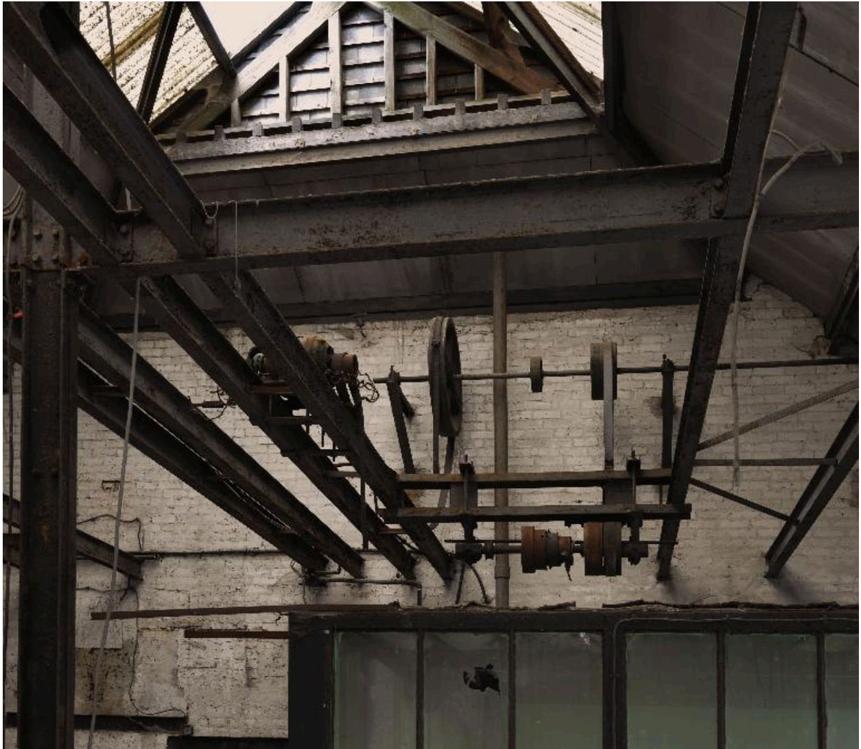
Système de poulies de l'ancien atelier de fabrication.
