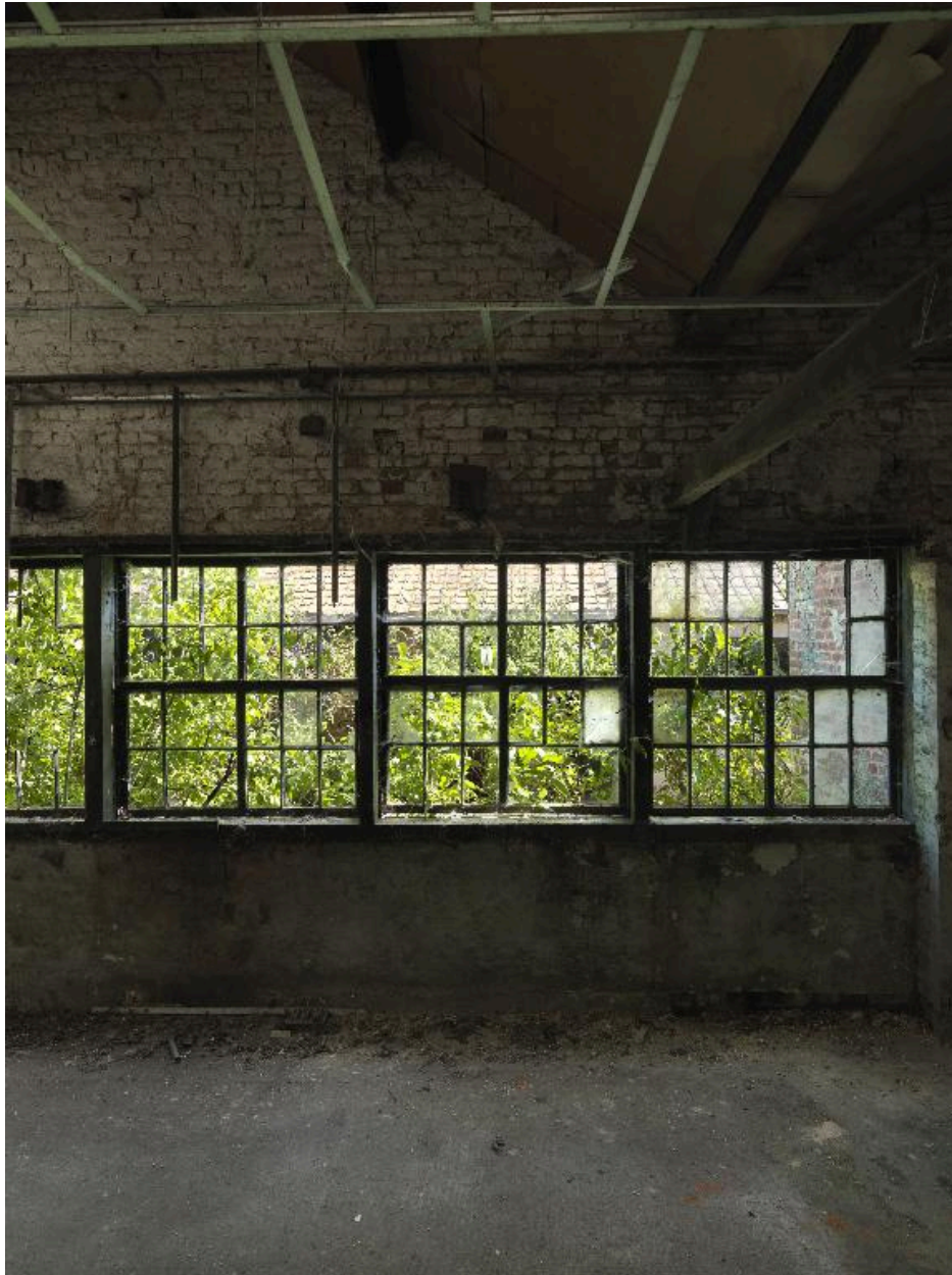
Ouvertures à guillotine de l'ancien atelier de fabrication secondaire.
