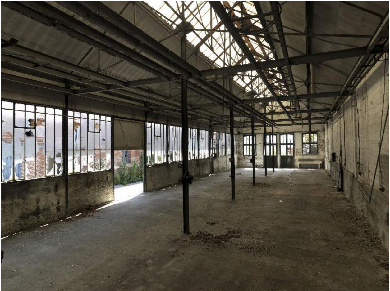
Vue intérieure des anciens ateliers de fabrication.
