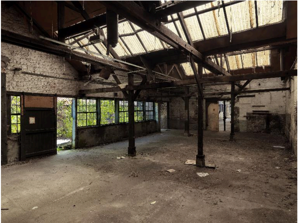
Ancien atelier de fabrication secondaire.
