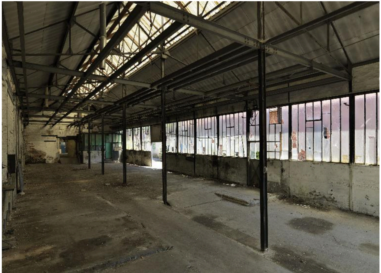
Vue intérieure des anciens ateliers de fabrication.
