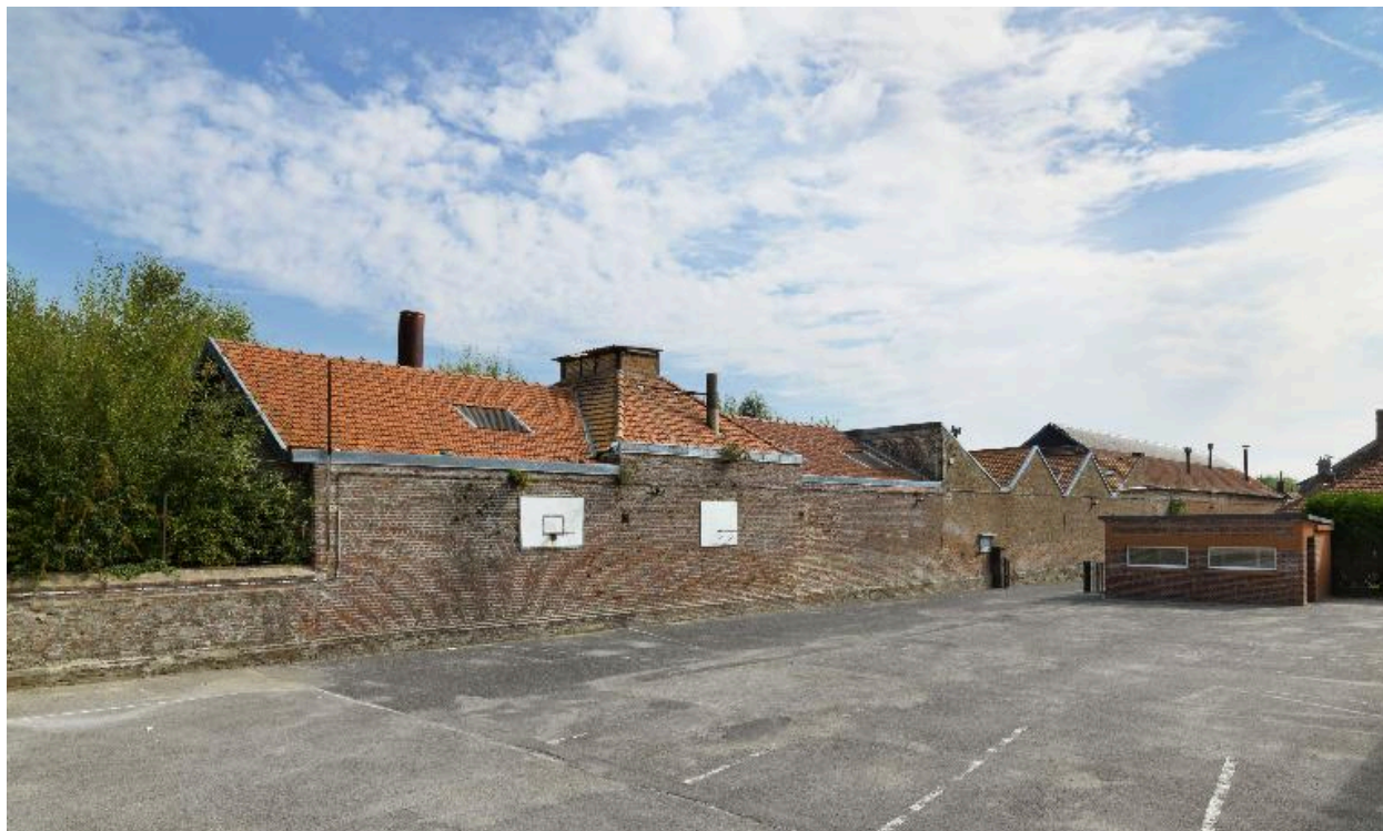
Vue des bâtiments de fabrication depuis la cour de l'école.
