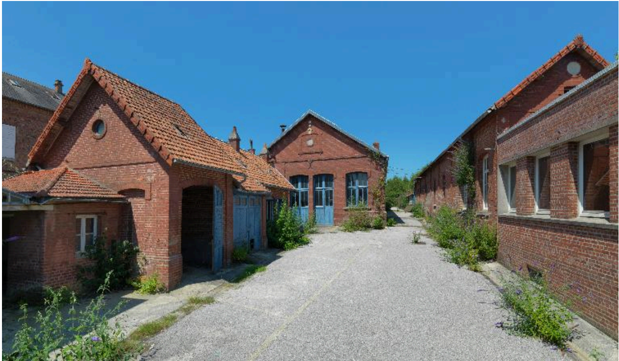
Vue générale depuis la rue Henri-Barbusse.
