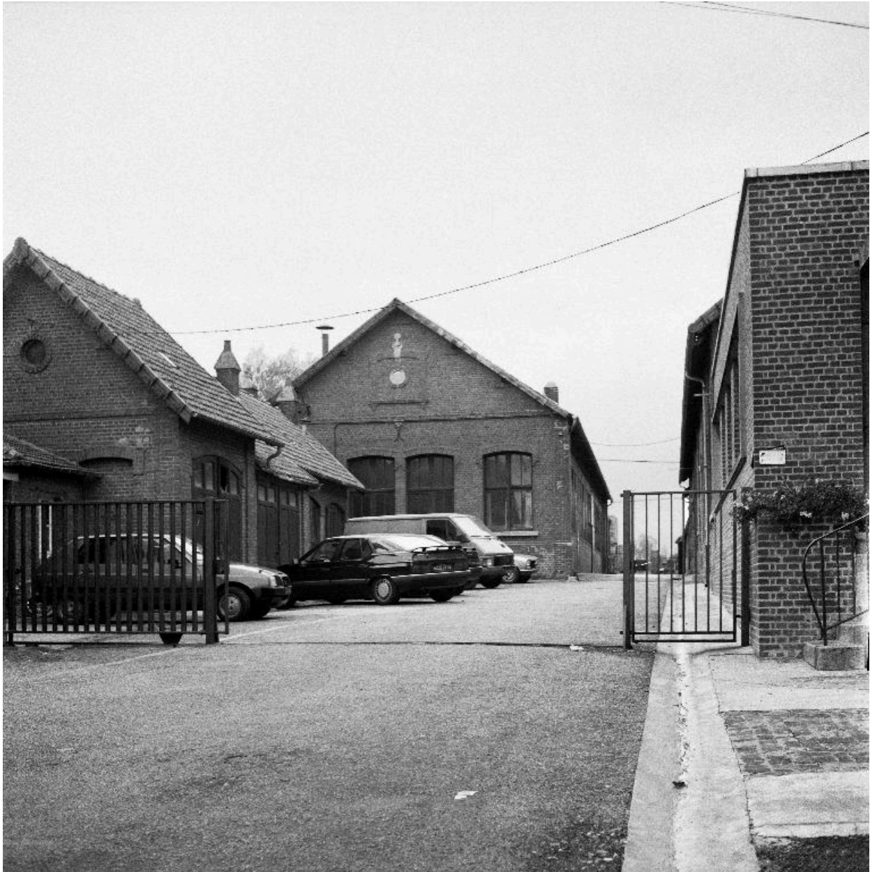
Atelier de fabrication, cantine, flanc sud-est, en 1990.
