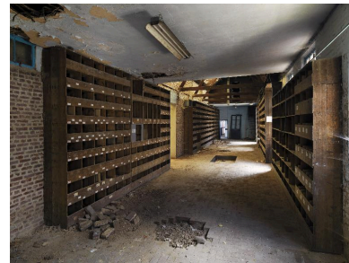
Vue intérieure de l'anciens magasin. Phot. Thierry Lefébure IVR22_20158000405NUC2A
