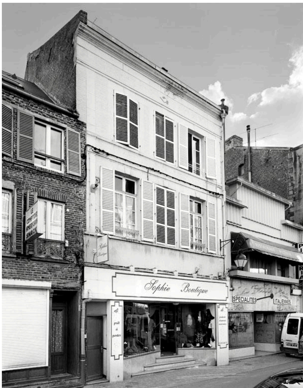
Vue de la façade sur rue.
