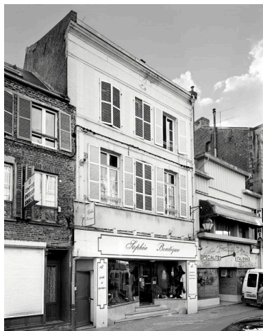
Vue de la façade sur rue. Phot. Thierry Lefébure IVR22_20020200827V
