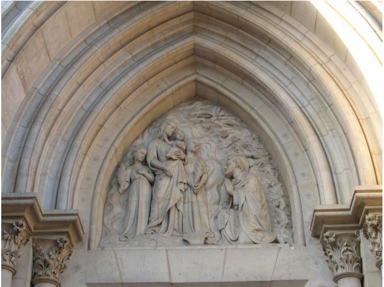
Vue de détail : tympan du portail est.
