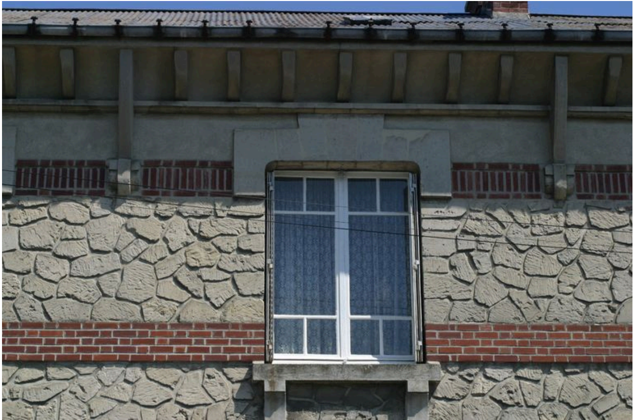
Détail d'une des baies de l'étage.
