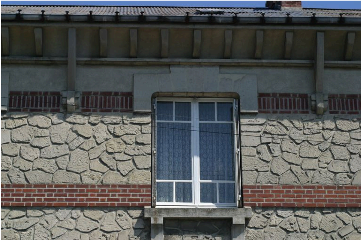
Détail d'une des baies de l'étage.
