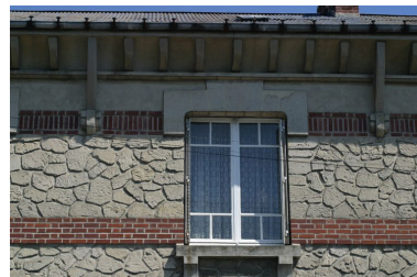
Détail d'une des baies de l'étage. Phot. Inès Guérin IVR22_20050200634NUCA
