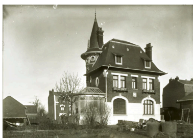
Photographie de fin de chantier prise par l'agence d'architecture de Paul Decaux. (AD Pas-de-Calais, 45J551). Vue de la façade arrière. Phot. Thibaut Pierre (reproduction) IVR32_20216200447NUCA
