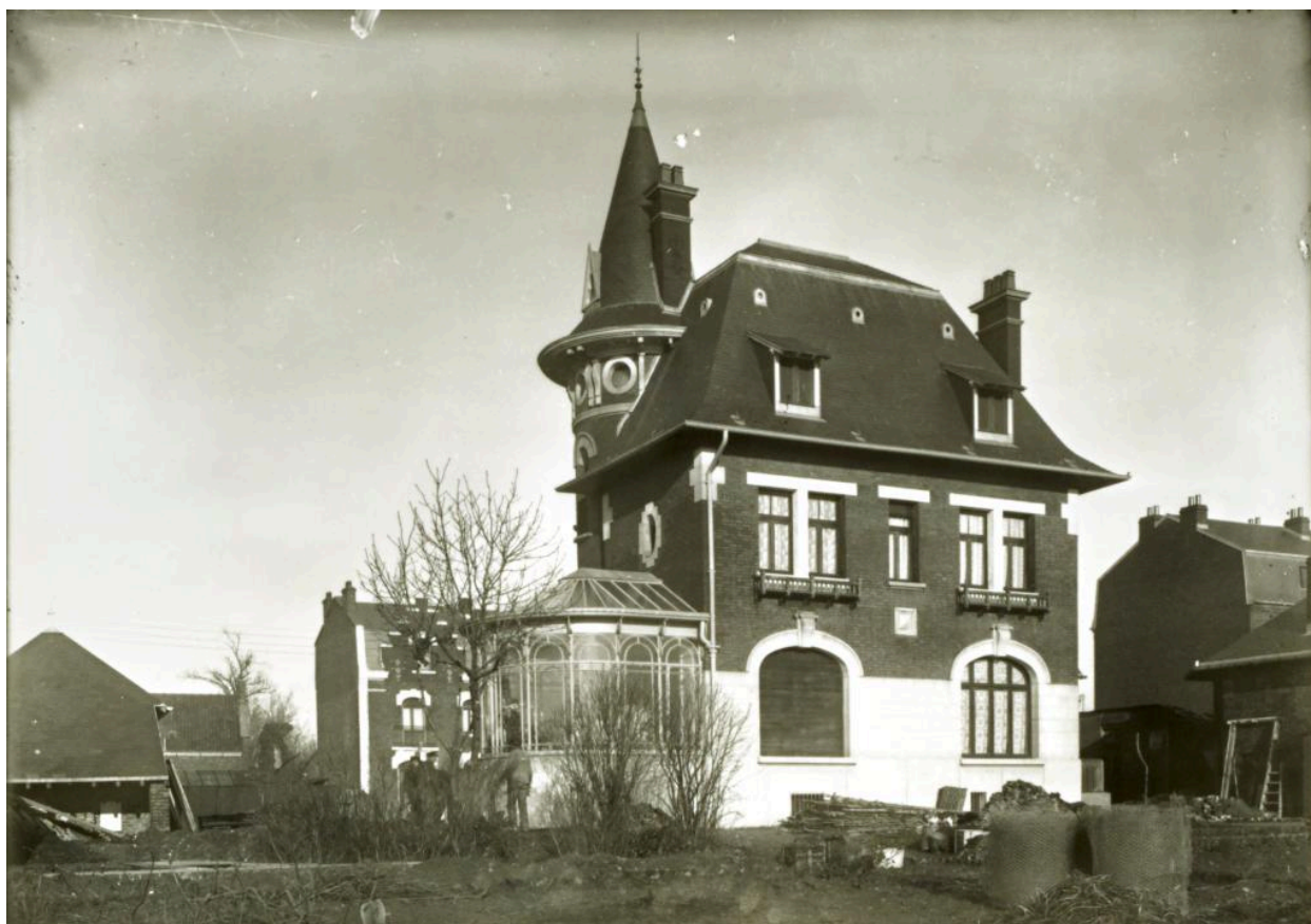
Photographie de fin de chantier prise par l'agence d'architecture de Paul Decaux. (AD Pas-de-Calais, 45J551). Vue de la façade arrière.
