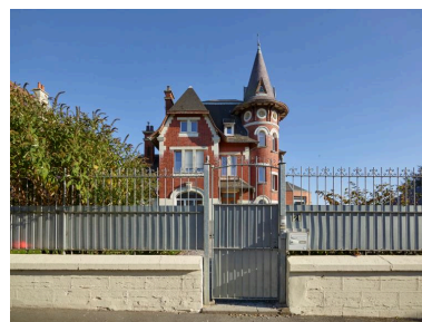
Vue depuis la rue de la République. Phot. Hubert Bouvet IVR32_20196201062NUC4A
