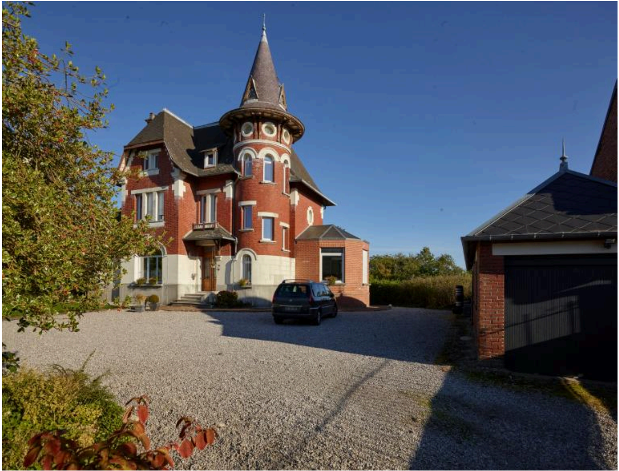
Vue générale avec le garage.
