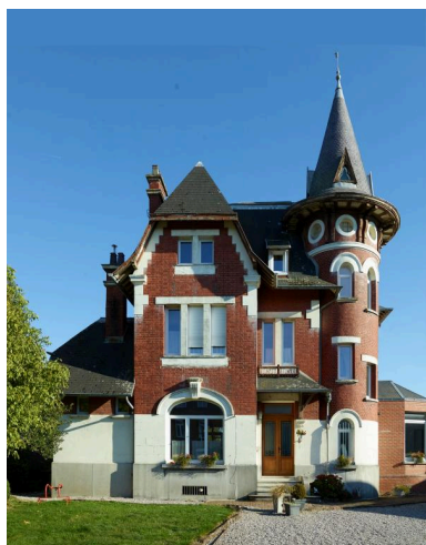
Vue générale de face. Phot. Hubert Bouvet IVR32_20196200540NUC4A
