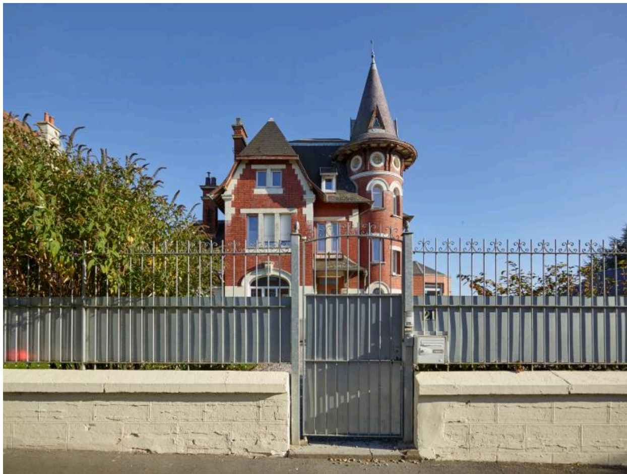
Vue depuis la rue de la République.
