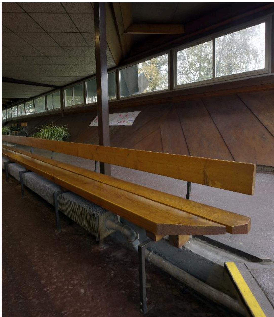
Vue de détail du système de chauffage.
