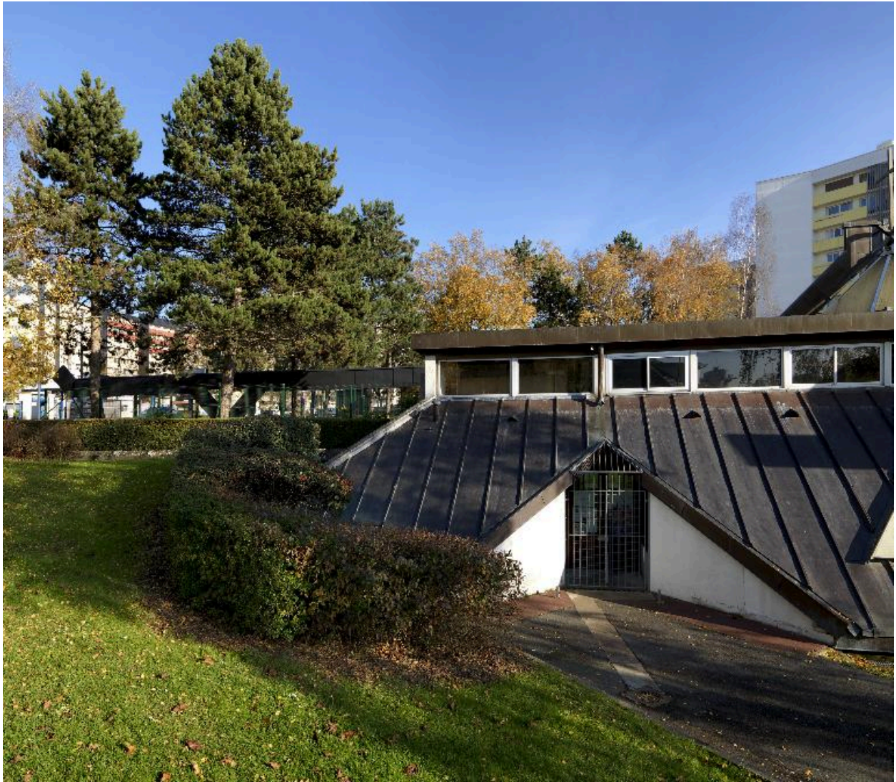
Vue de l'entrée au niveau inférieur.
