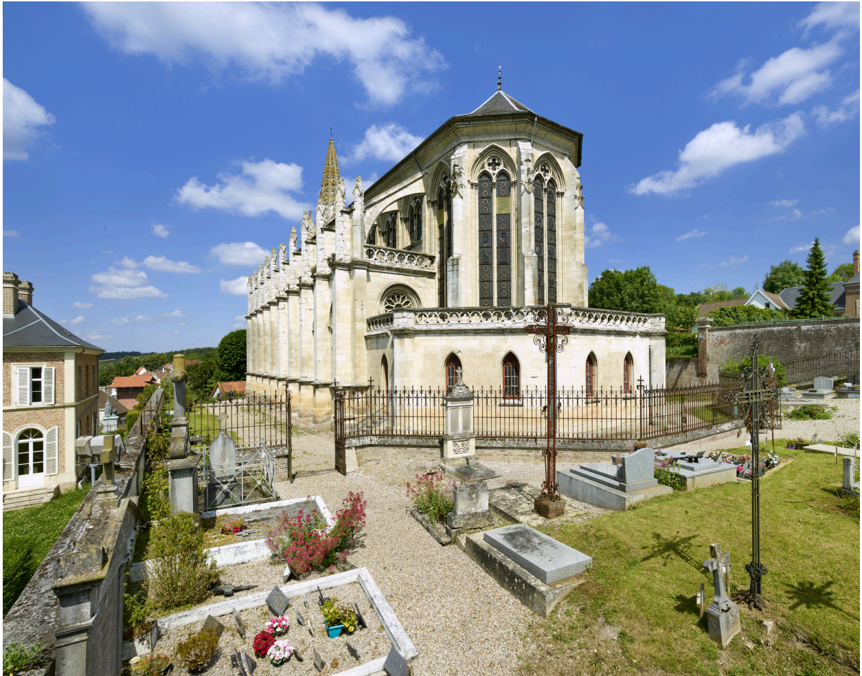
Vue sud-est de l'église, depuis le cimetière.
