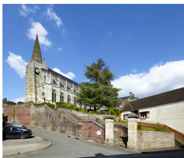
Vue sud de l'église, depuis la route. Phot. Thierry Lefébure IVR32_20258000296NUCA
