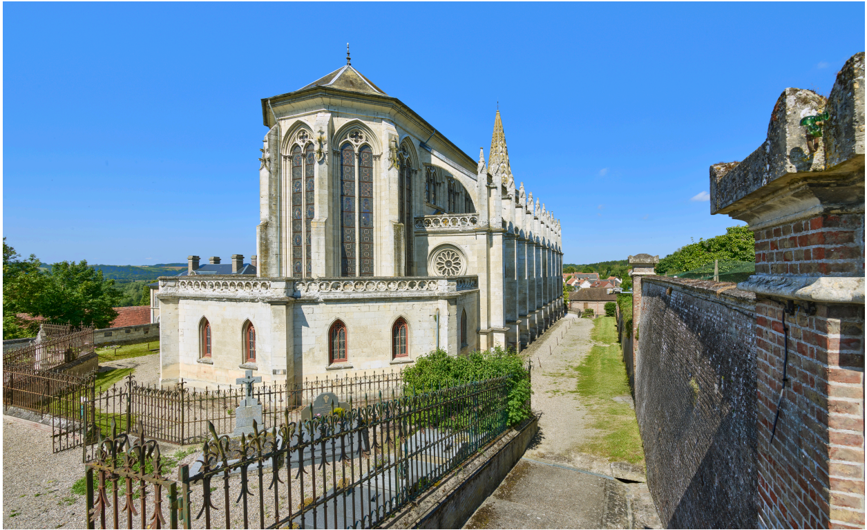
Vue nord-est de l'église, depuis le cimetière.
