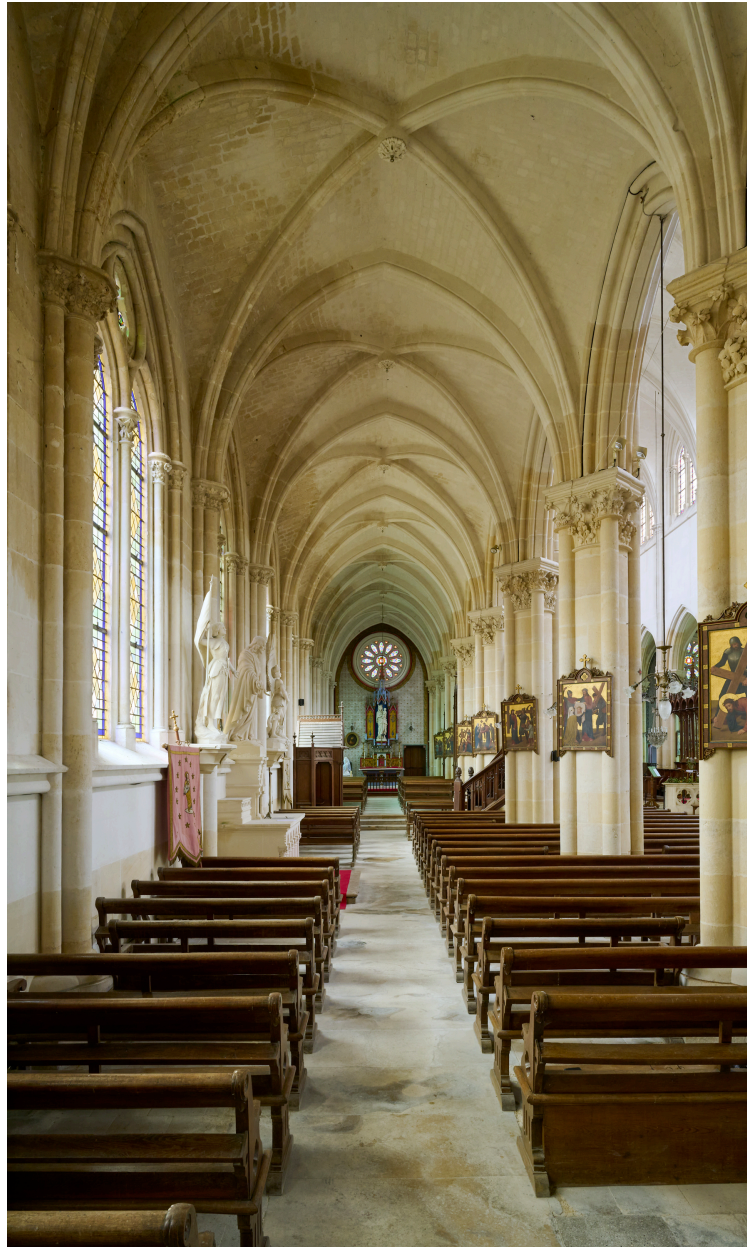
Intérieur, vue du collatéral nord, depuis l'ouest.
