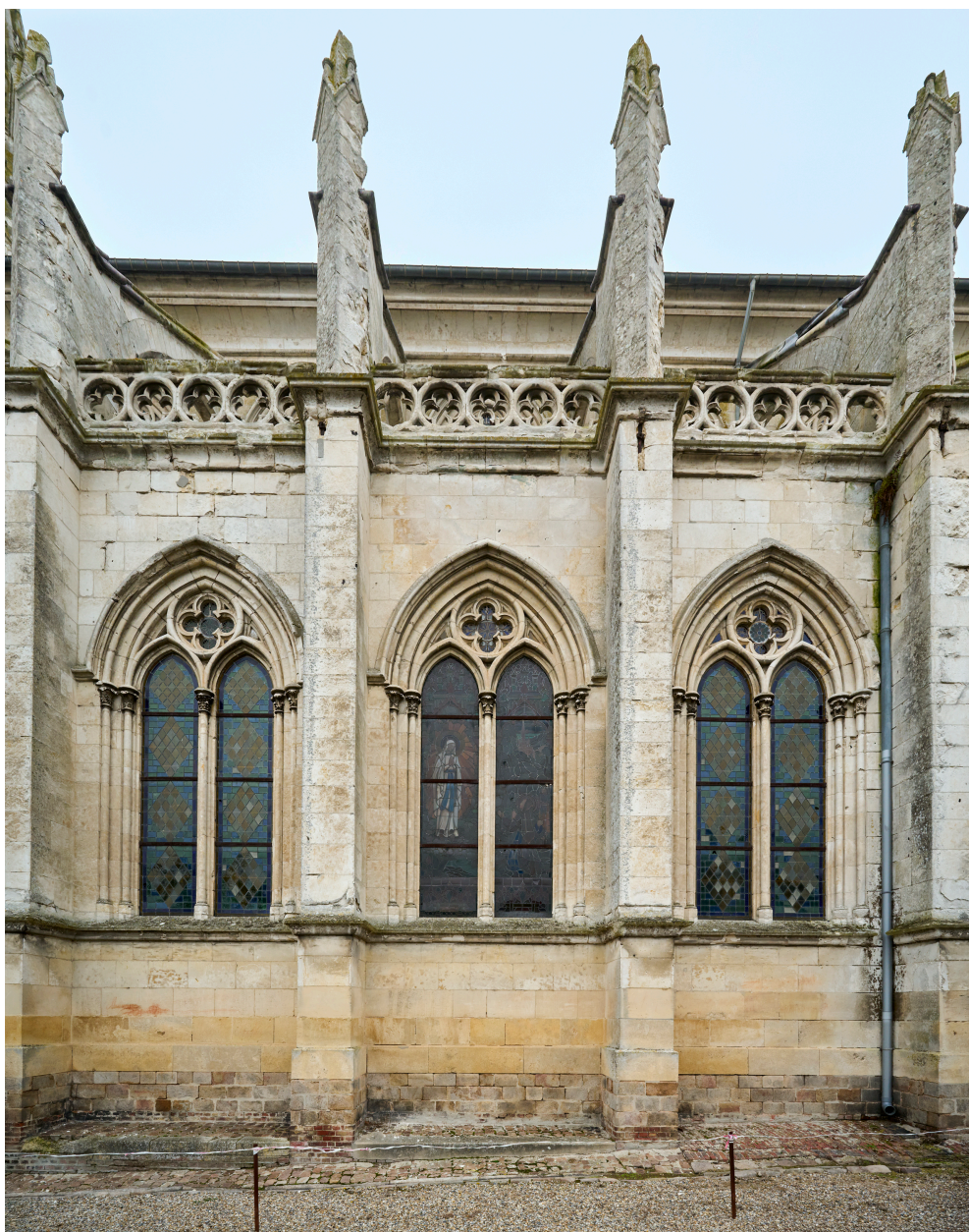
Détail de l'élévation sud de la nef.
