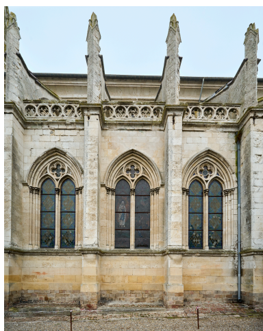
Détail de l'élévation sud de la nef. Phot. Thierry Lefébure IVR32_20258000425NUCA
