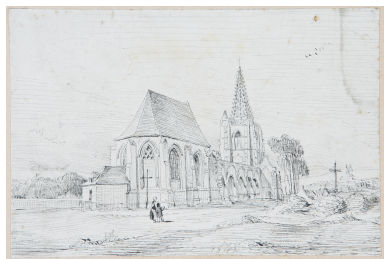
L'ancienne église de Long pendant la destruction de la nef, dessin des frères Duthoit, [s.d.] (Archives du musée de Picardie, Duthoit, XV-57). Repro. Musée de Picardie, Autr. Aimé Duthoit, Autr. Louis Duthoit IVR32_20258011193NUCA
