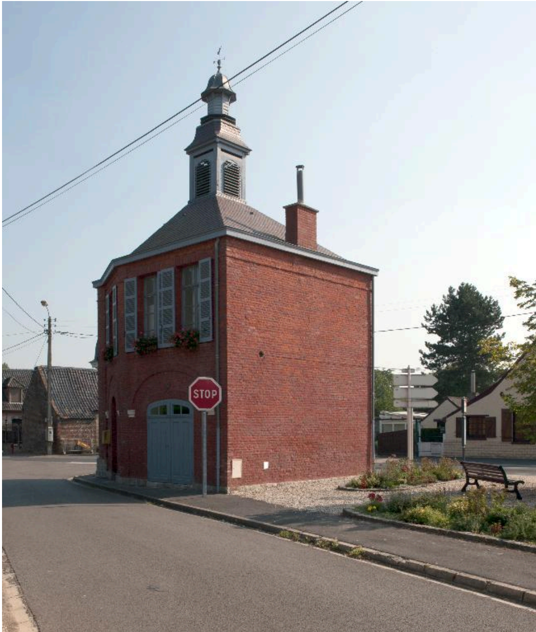
Vue de trois quarts : façade de la mairie et élévation postérieure.
