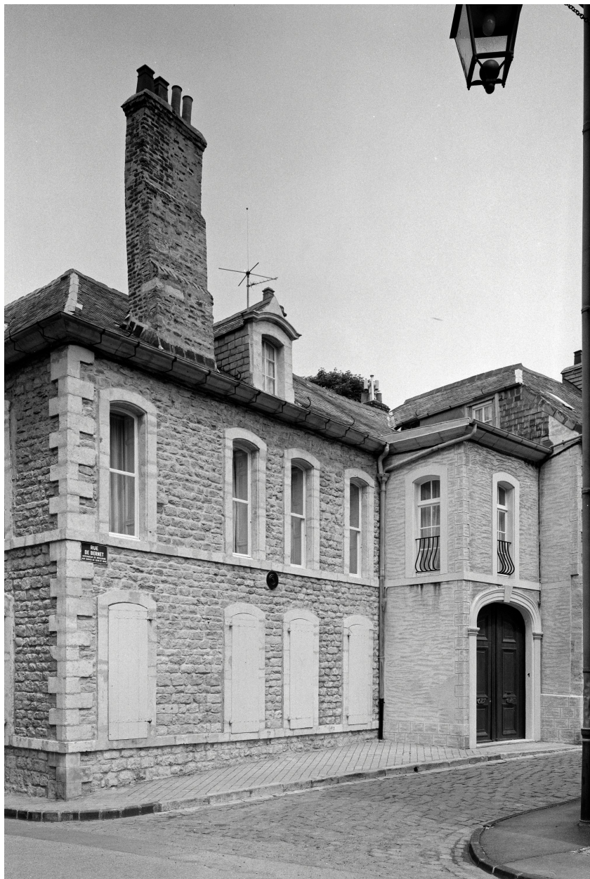
Vue de profil sur rue de Bernet.
