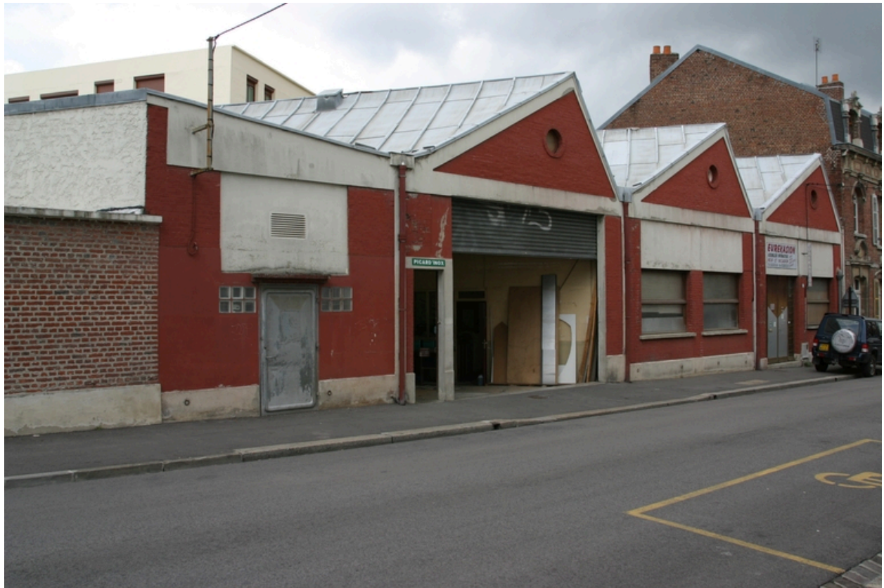
Façade des ateliers, rue Condorcet.
