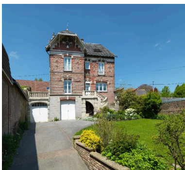
Vue d'ensemble de la façade principale. Phot. Thierry Lefébure IVR22_20138000175NUC2A
