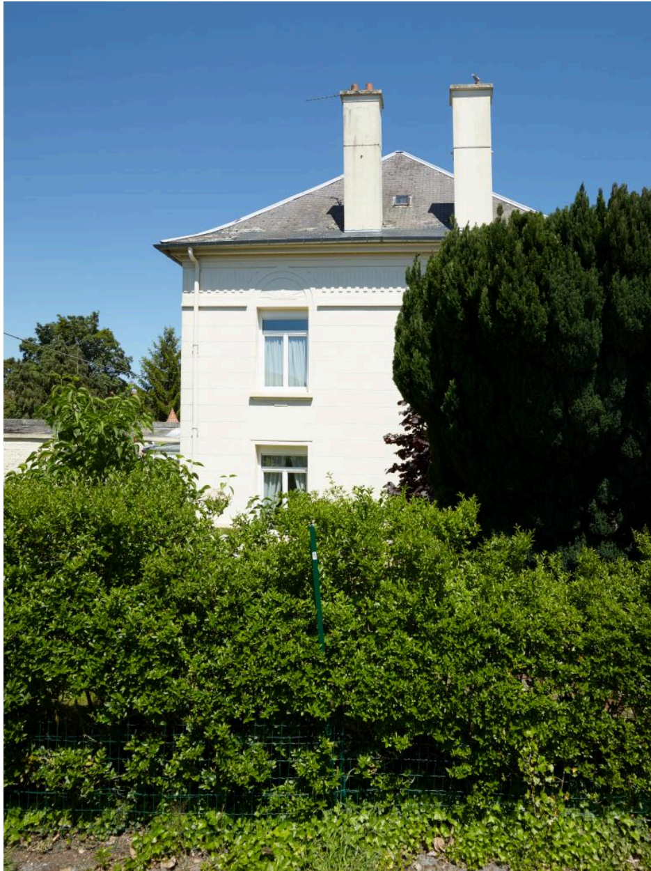
Vue de la façade latérale gauche.
