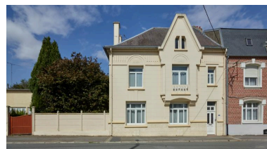
Vue générale de la façade depuis la rue de Douai. Phot. Hubert Bouvet IVR32_20196200460NUC4A
