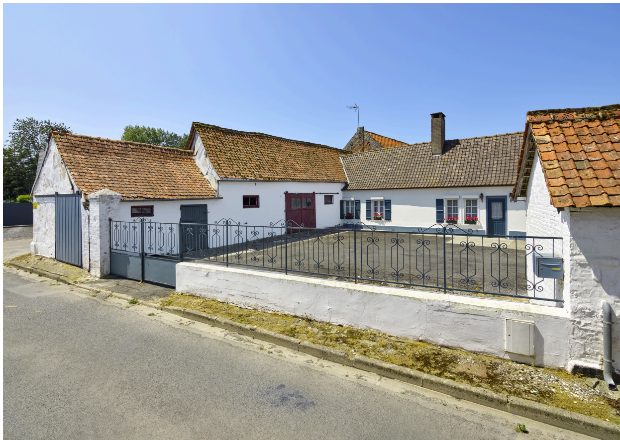
Vue de la maison et de la grange, depuis l'ouest.
