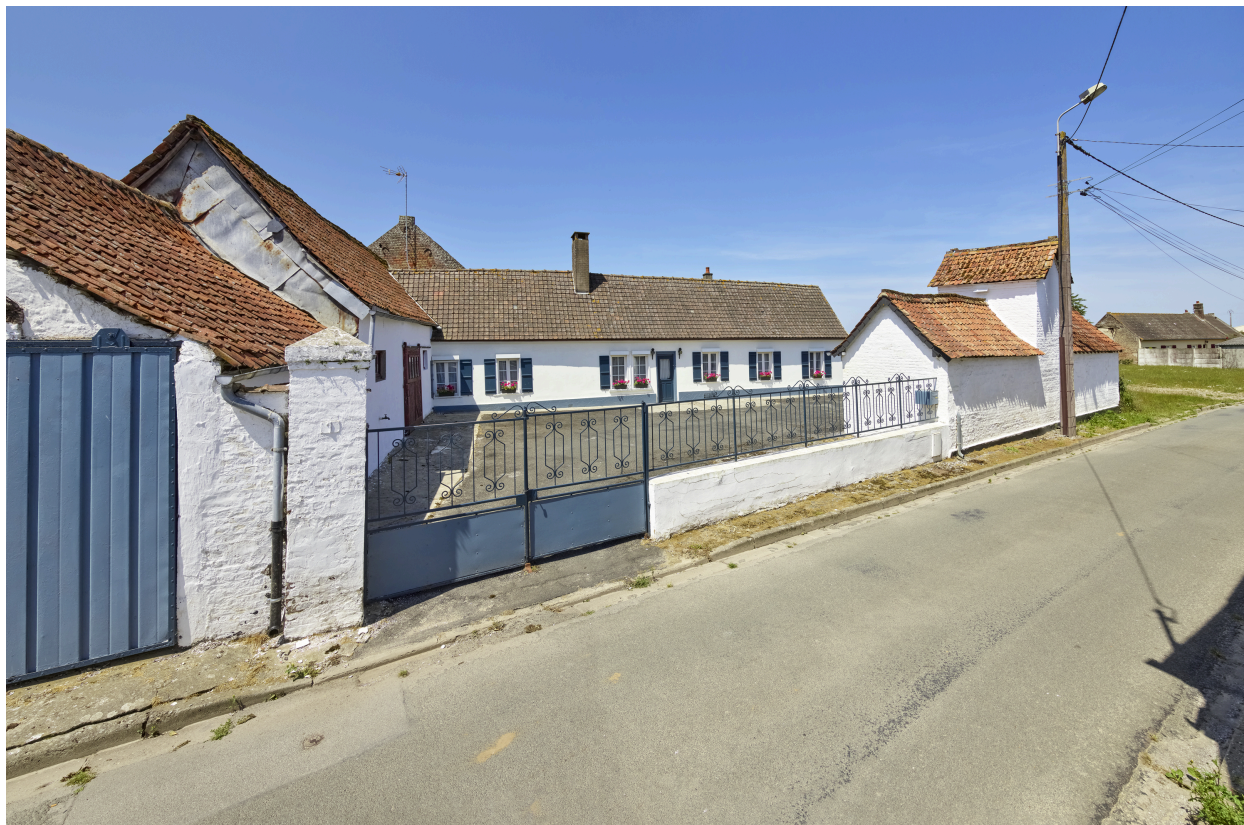
Vue de la cour, de la maison et du pigeonnier, depuis l'est.
