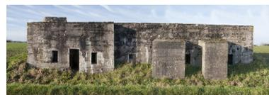
Elévation est. A gauche, deux entrées protégées de porches pare-souffle. Sur le toit, les vestiges, peut-être, du troisième porche
