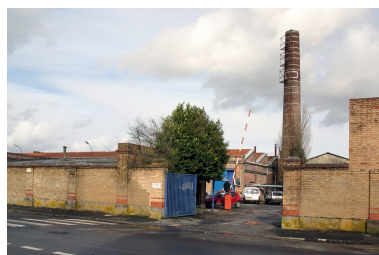
Entrée secondaire de l'usine.
