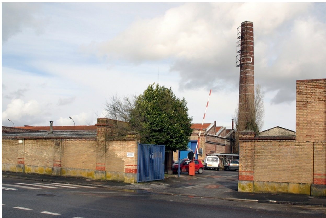
Entrée secondaire de l'usine.
