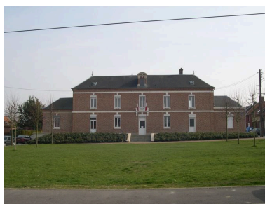
La mairie. Phot. Isabelle Barbedor IVR22_20038010140NUCA
