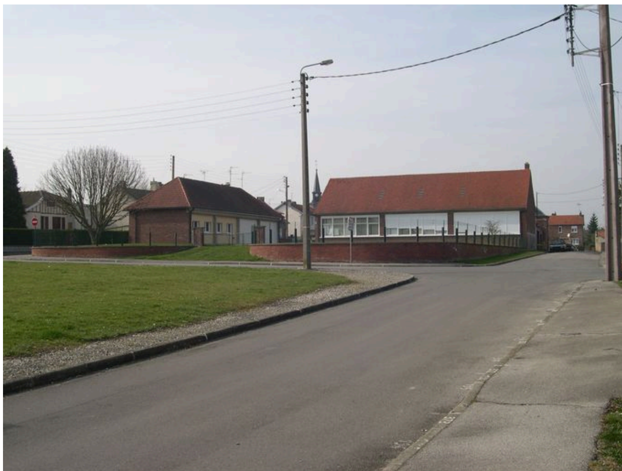
Vue de situation de l'école.
