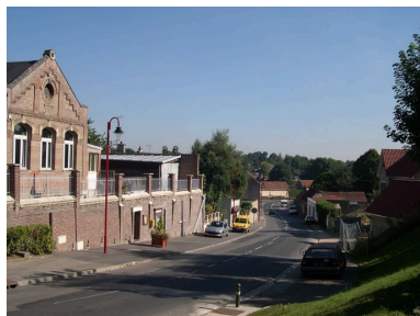
La rue Paul-Cornet, vue depuis le monument aux morts. Phot. Isabelle Barbedor IVR22_20038010739NUCA
