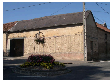
Le puits aménagé au croisement de la rue Paul-Cornet et de la rue des Bois. Phot. Isabelle Barbedor IVR22_20038010741NUCA
