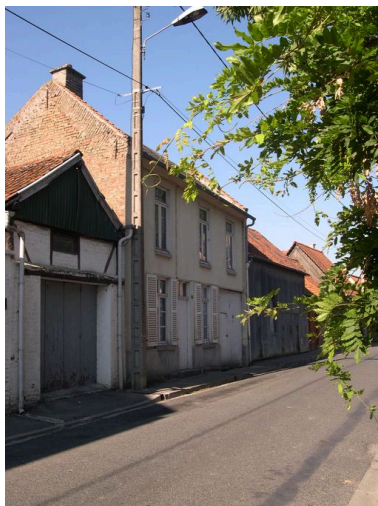
Maison, 7 et 9 rue des Bois. Phot. Isabelle Barbedor IVR22_20038010746NUCA
