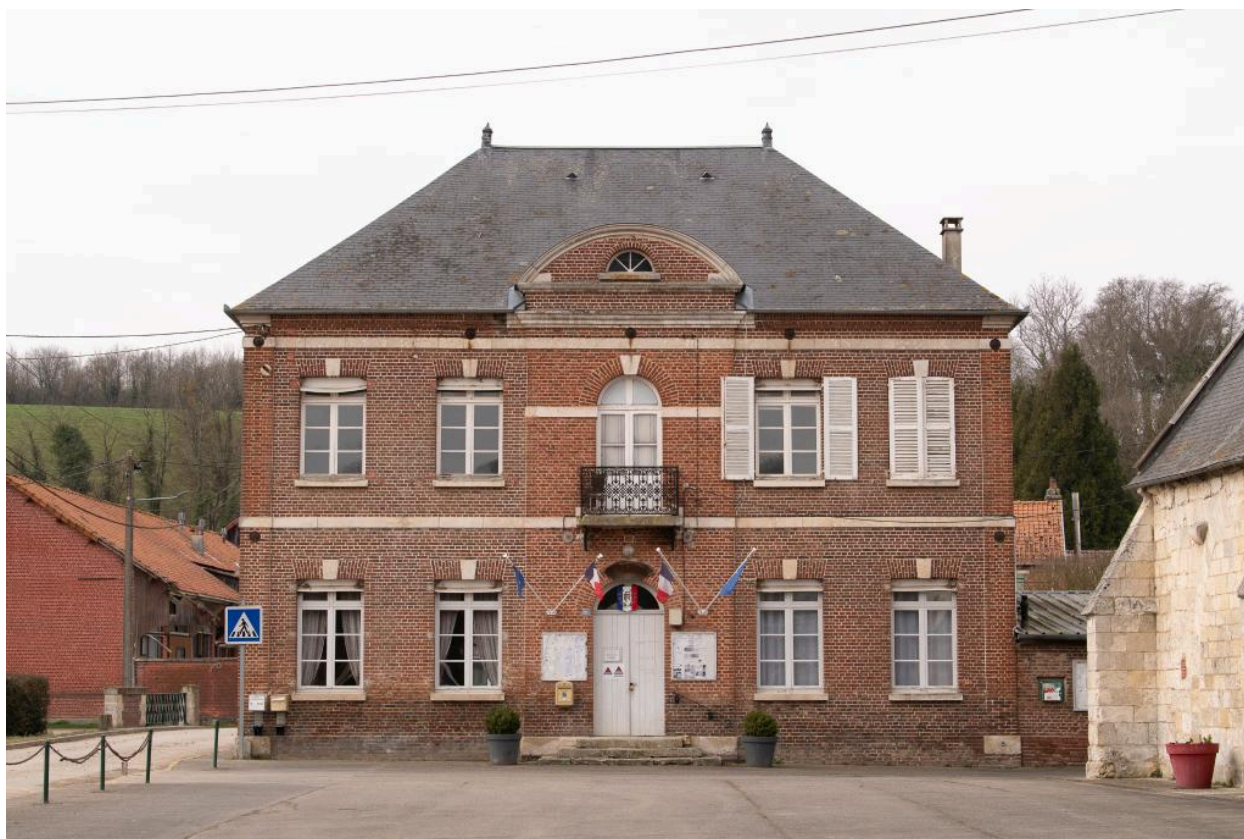
Mairie-école vue depuis l'est.
