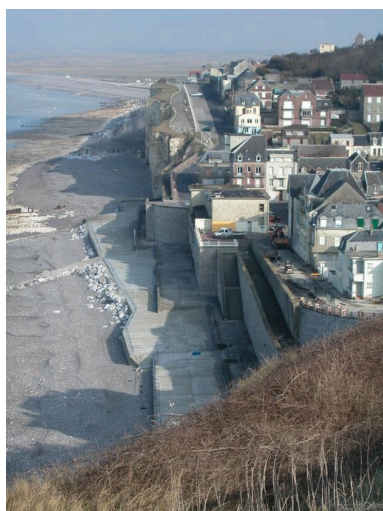
La digue en amont du casino. Phot. Elisabeth Justome IVR22_20038005438NUCA
