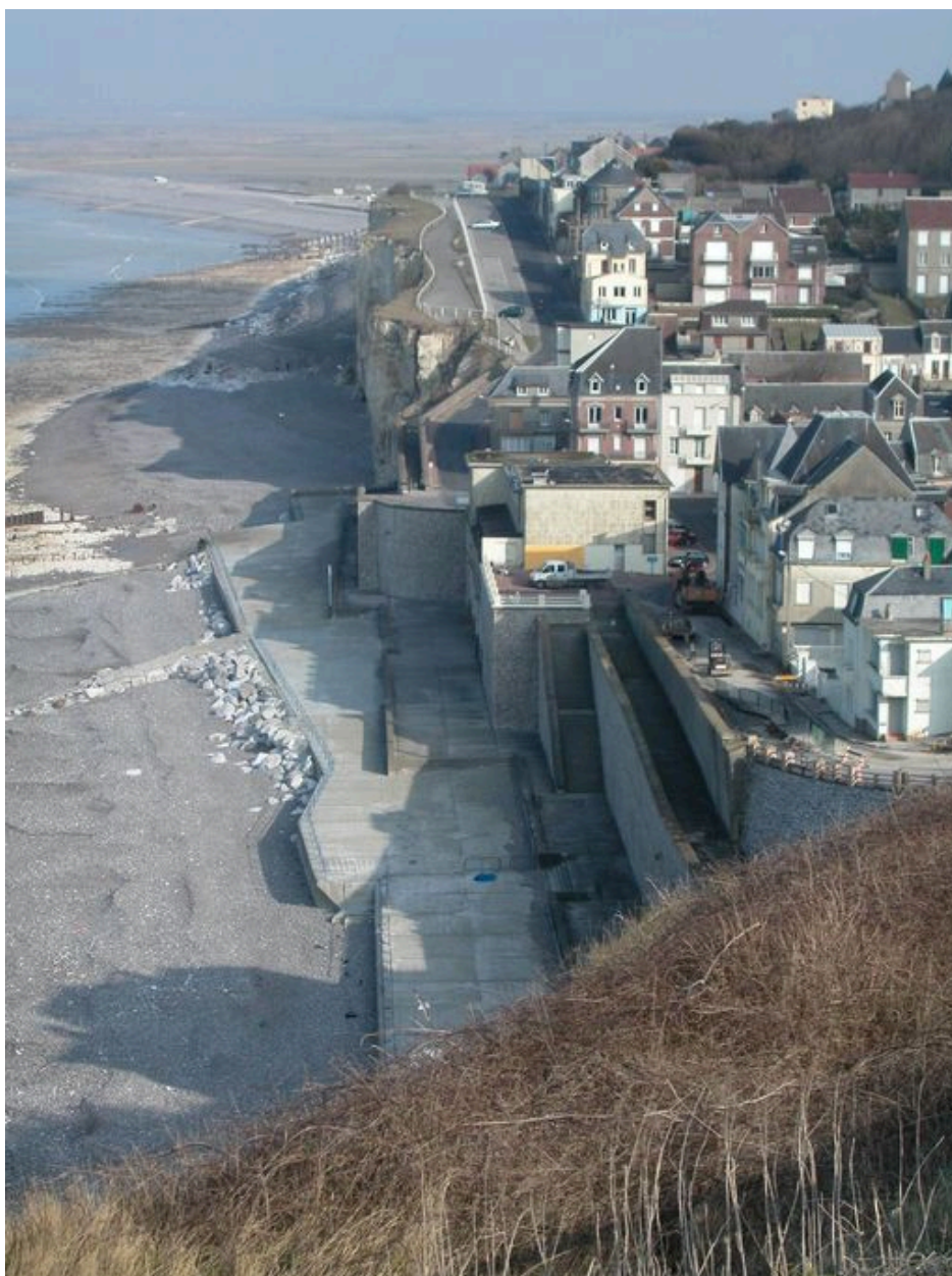
La digue en amont du casino.
