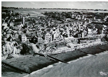
La digue en cours d'aménagement, carte postale, 3e quart 20e siècle (coll. part.). Phot. Monnehay-Vulliet Marie-Laure IVR22_20048000099NUCAB
