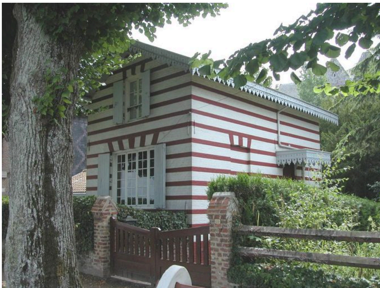
Vue d'ensemble depuis la digue.
