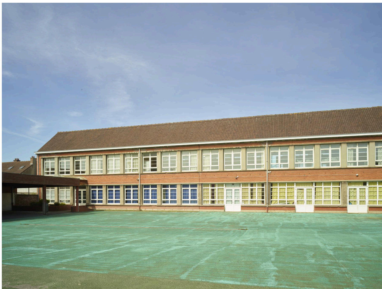
Élévation des salles de classe sur la cour, vers le nord-ouest.
