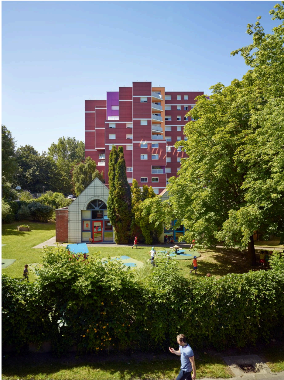
Le groupe scolaire et sa cour de récréation, devant les immeubles d'habitation de l'îlot 13 (vue depuis le sud).
